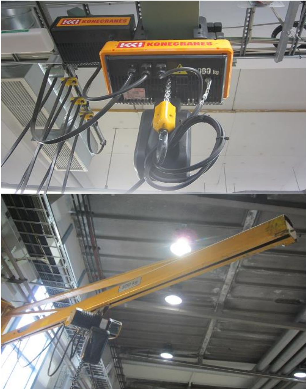
Kuva 3.1. Ketjunostin I-palkissa ja seinäkääntöpuomissa
