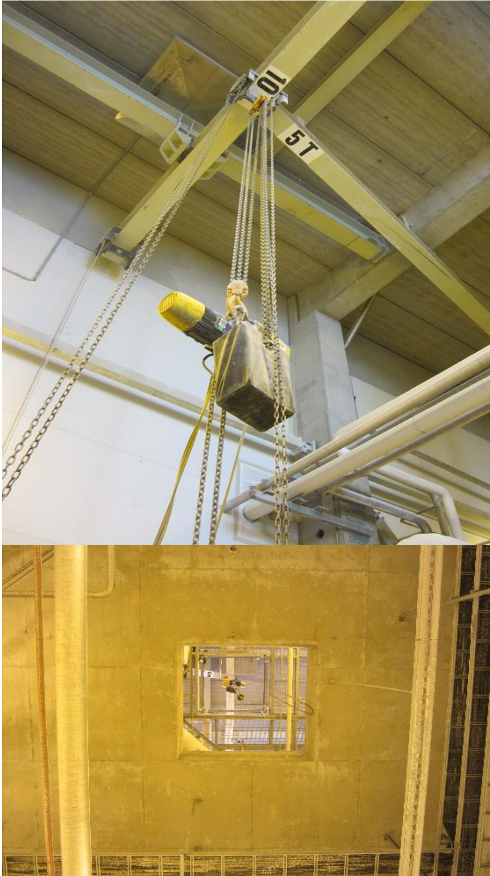
Kuva 9.3. Kaustisoinnin nostoaukon nostin kolmannesta sekä ensimmäisestä kerroksesta kuvattuna
