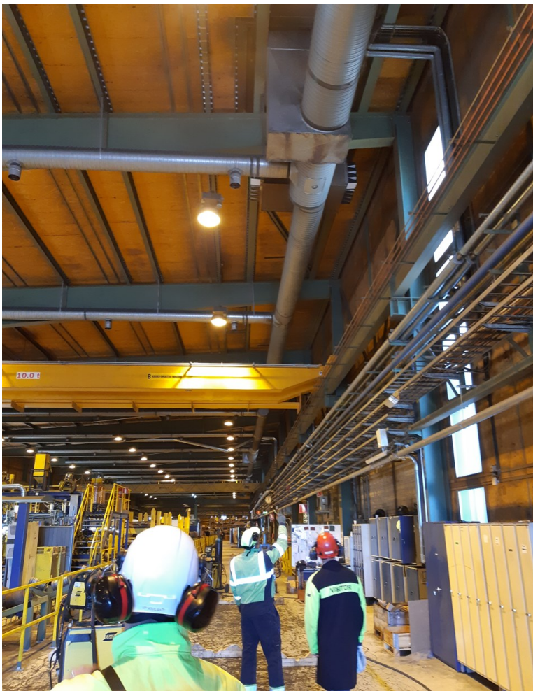
KUVA 8. Kattokone sekoittavalla ilmanjaolla varusteluhallissa ja siltanosturi
