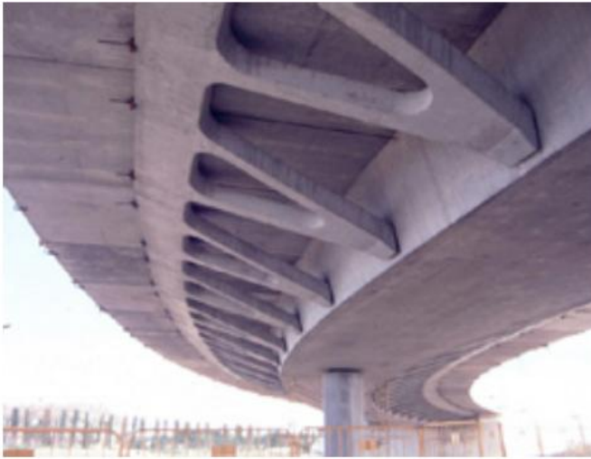
KUVA 26. Tuettu kansilaatta kotelopalkkisillassa (Calavera ym. 2004, 18)
