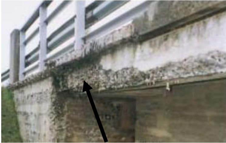
KUVA 4. Sillan reunapalkin ja kannen pakkasrapautumista ( SILKO 2.211, 2008, muokattu)
