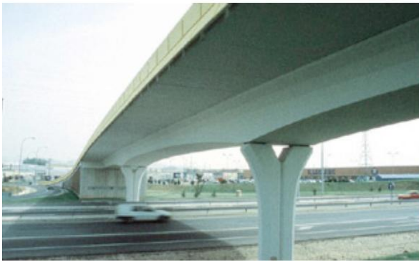
KUVA 27. Ulokkeellinen kansilaatta kotelopalkkisillassa (Calavera ym. 2004, 20)
