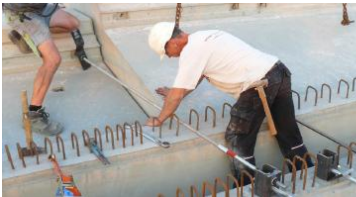
KUVA 16. Vioelementin vetotangot ( Spaencom n.d, muokattu)
