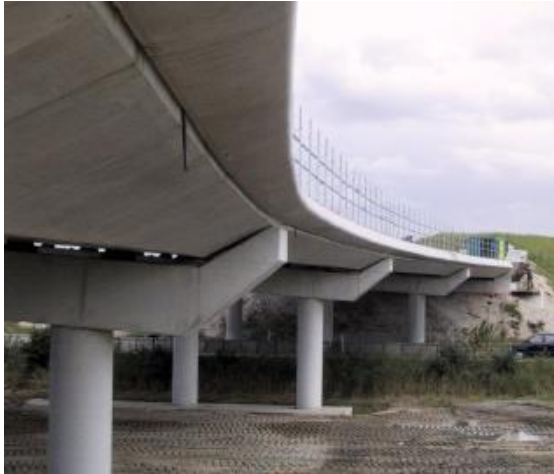
KUVA 11. Kaareva kotelopalkkisilta (Calavera ym 2004, 21)
