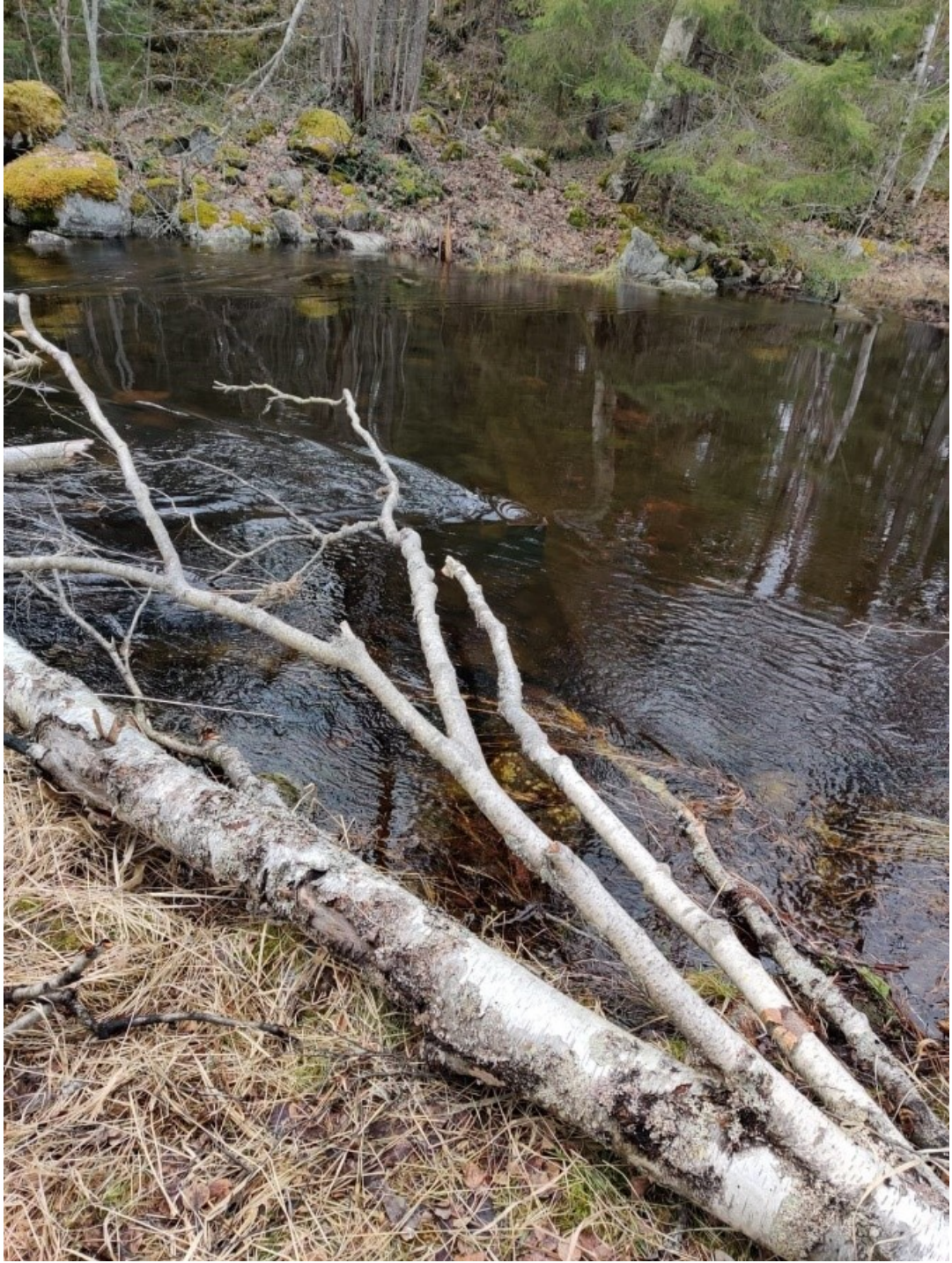
Kuva 2. Malloksen pohjapato toukokuussa 2021 ylivesiaikaan.
