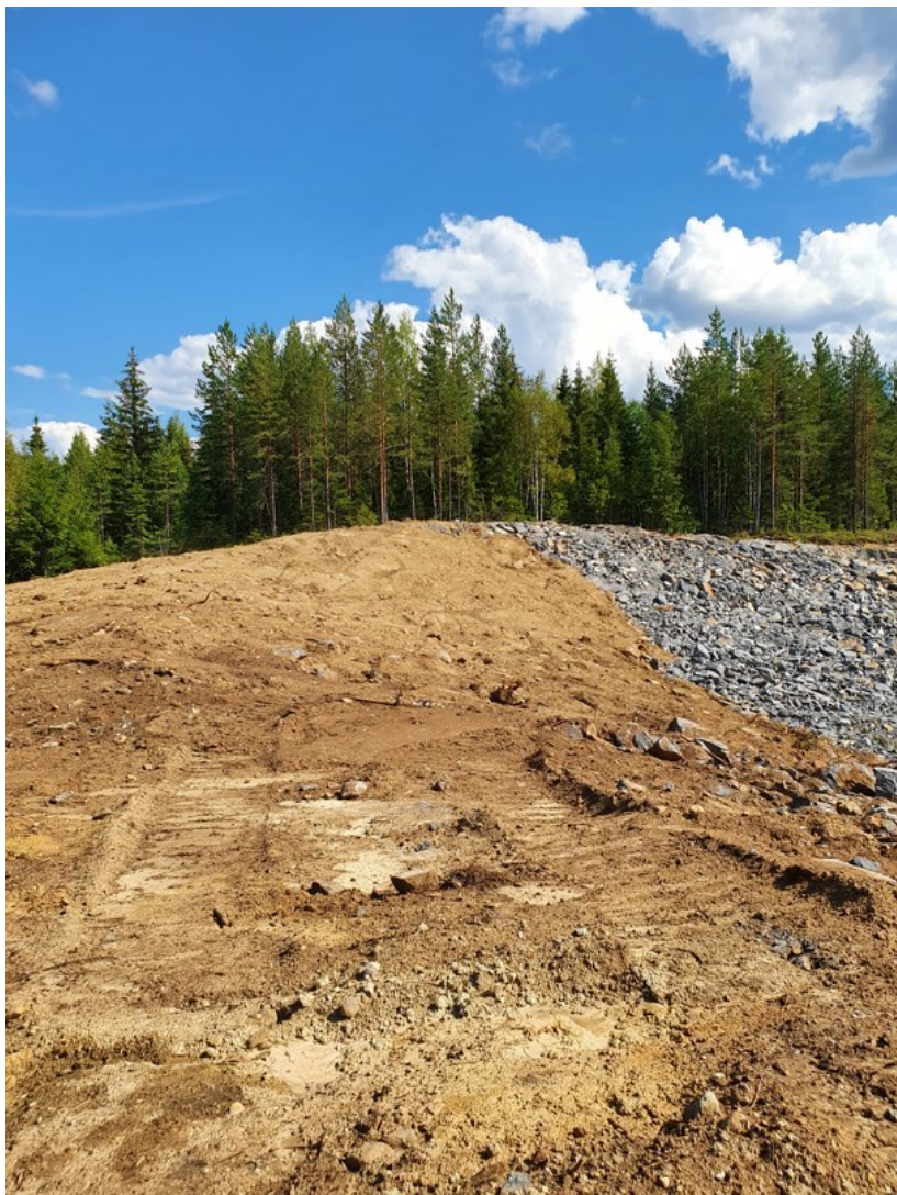
KUVA 10. Kallionottoalueen muotoilua (Kainulainen 2021a)
