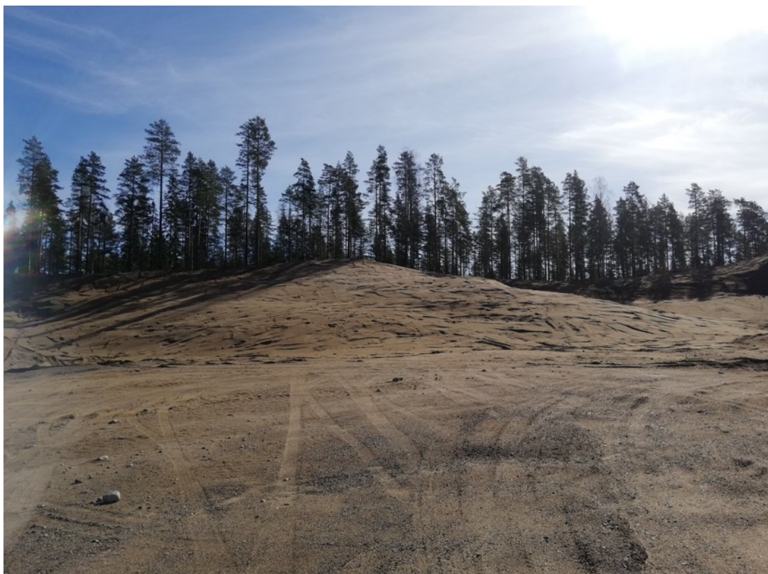
KUVA 8. Maa-ainesalueen luiskatut ottorintaukset (Kainulainen 2020)
