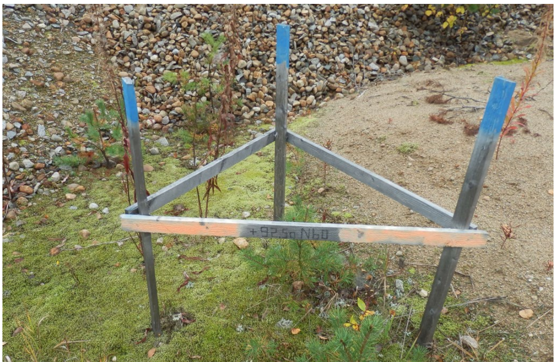
KUVA 5. Korkopukki osoittamassa alueen ottotasoa (Turunen 2017)
