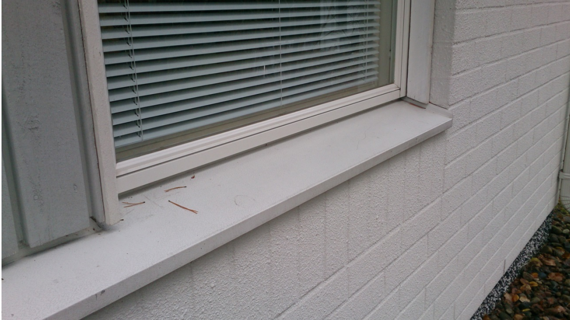
KUVA 8. Ulkoseinä ja ikkuna
