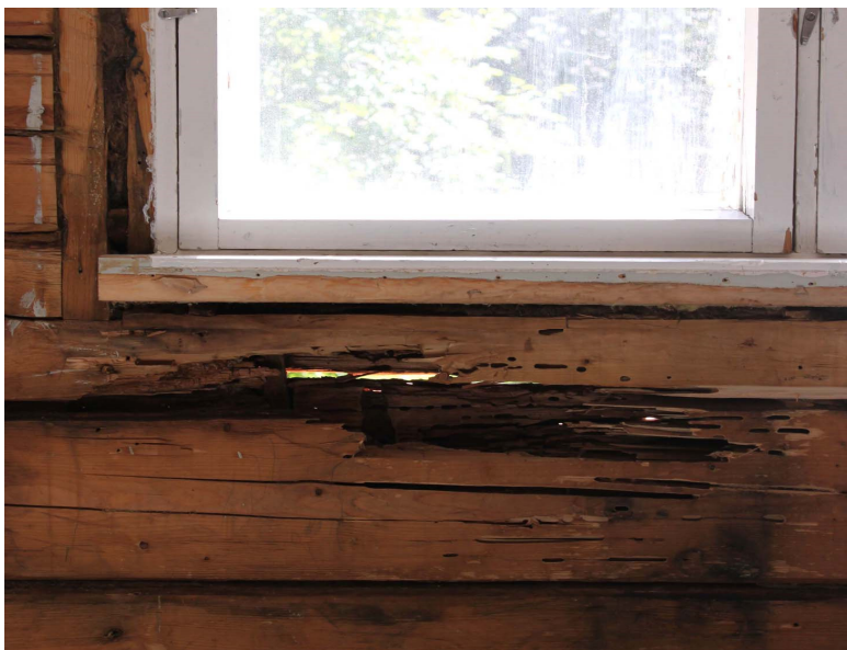
KUVA 3. Yksilasinen ikkuna, josta pellitykset puuttuvat
