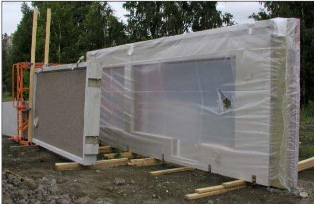
Kuva 6. Elementin muovihuputus (Teriö 2003)
