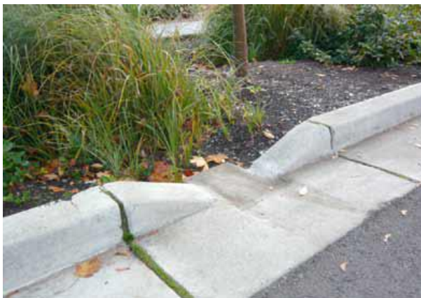
Kuva 32. Reunakiven aukko, joista hulevesi johtuu painanteeseen. Kuva Seattle (Kuntaliitto 2012.)
