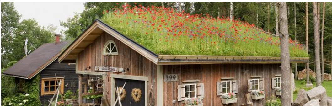
Kuva 8. Ohutrakenteinen viherkatto . ( Icopal Oy.)
