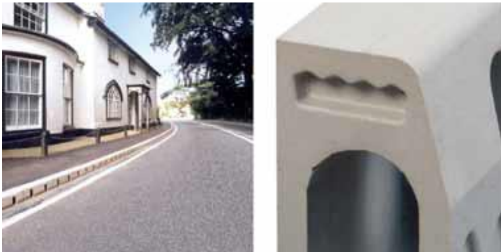
Kuvat 30 ja 31. Hulevesikanavana toimiva reunakivi. (Kuntaliitto 2012.)
