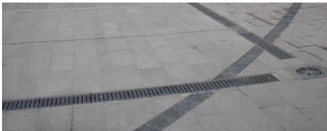
Kuva 29. Ritoläpäälysteiset vesikourut. (Mikkola 2010.)
