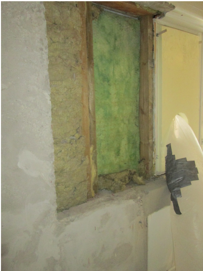
Kuva 5. Ulkoseinärakenne purkutyön jälkeen. Kuva Matti Toppi
