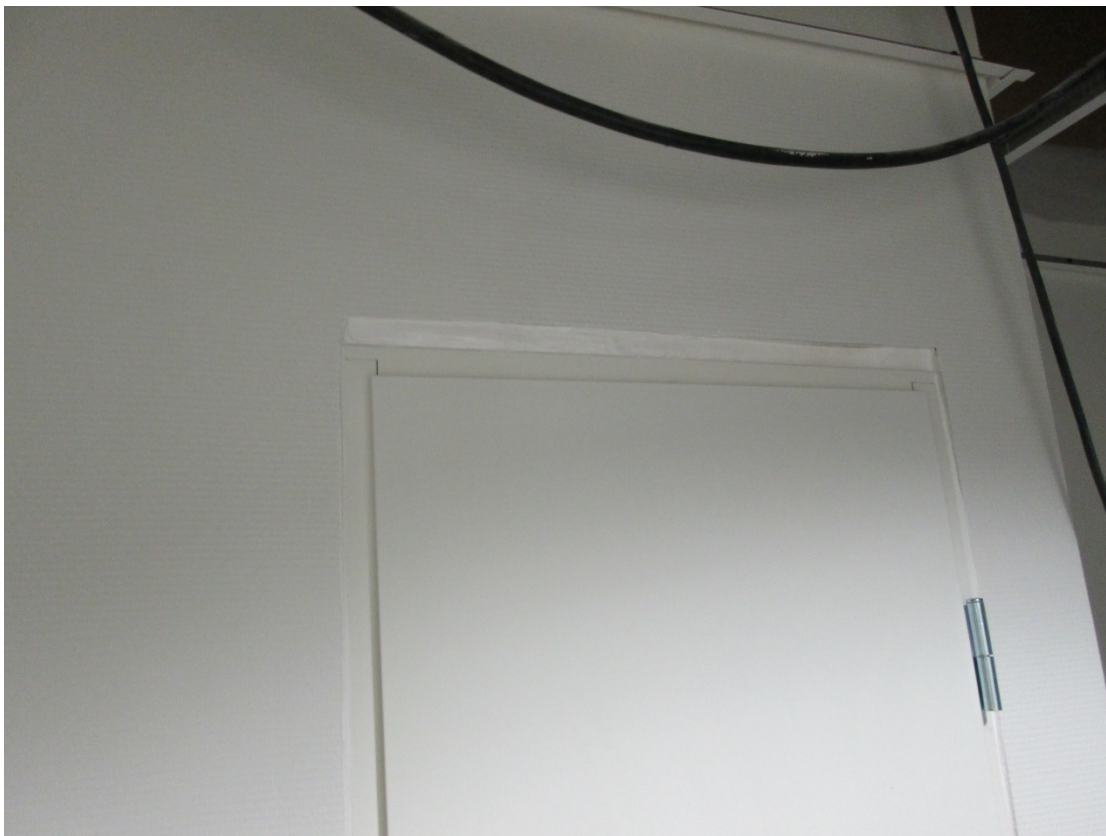
KUVA 9. Välioven karmin ja väliseinän tiivistys. Kuva Matti Toppi
