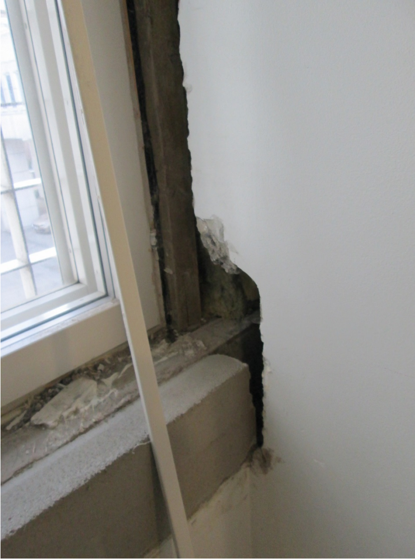
Kuva 3. Pilarin ja ulkoseinän liittymä. Kuva Matti Toppi
