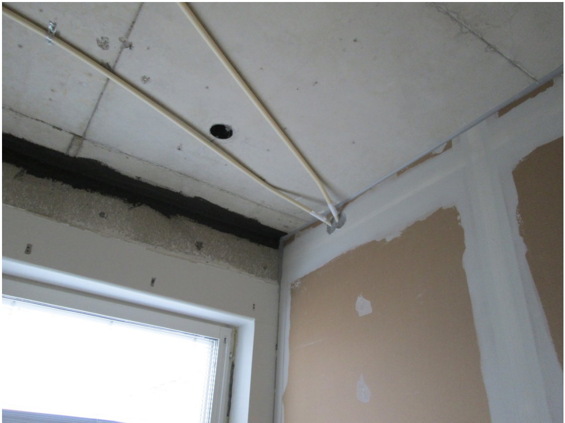
Kuva 4. Välipohjan liittyminen ulkoseinärakenteeseen. Kuva Matti Toppi
