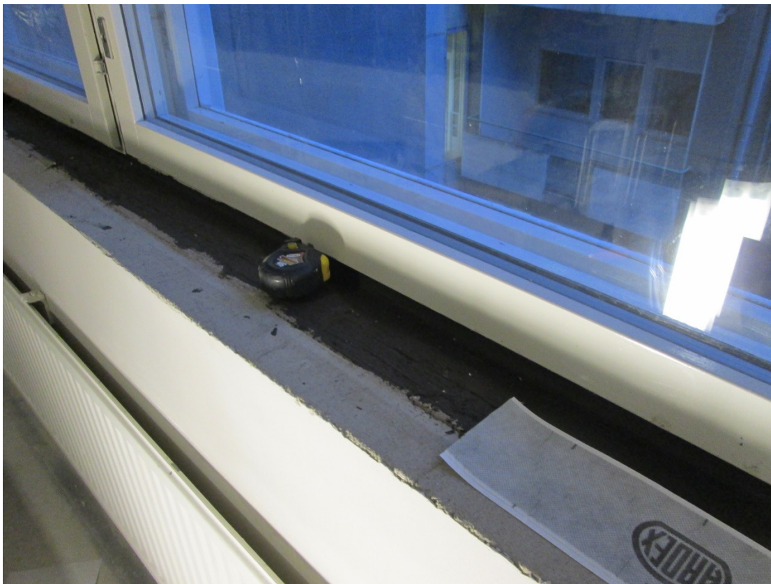
Kuva 1. Ikkunaliittymän ja ulkoseinärakenteen välinen tiivistyskorjaus. Kuva Matti Toppi
