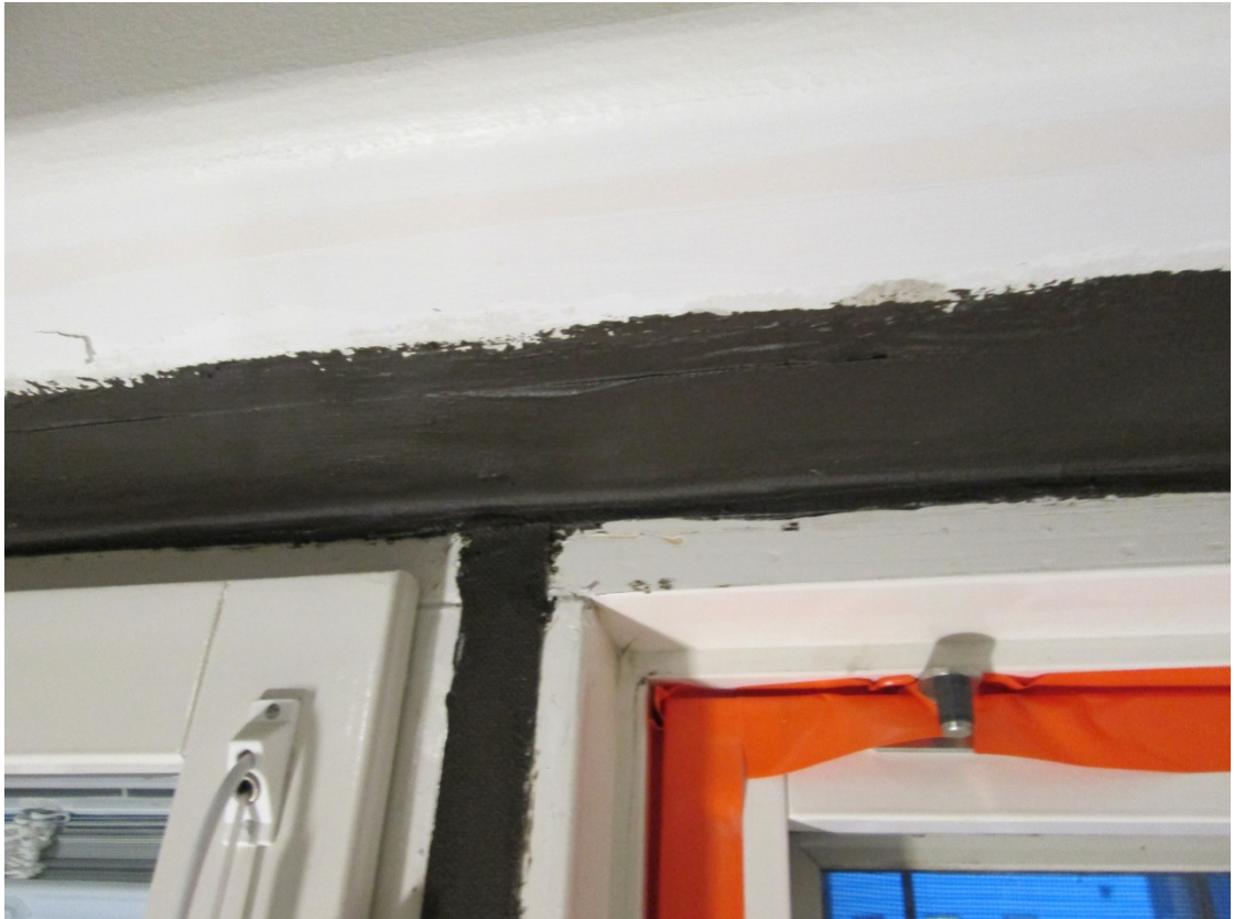
Kuva 6. Ikkunakarmin tiivistys. Kuva Matti Toppi
