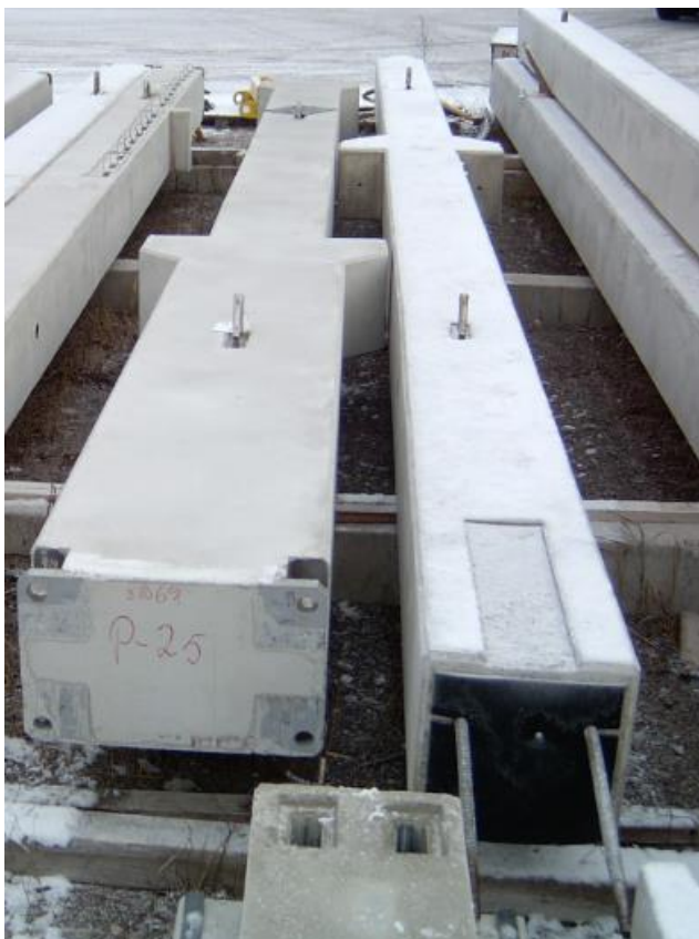
Kuva 8. Tyypillinen betonipilari, jossa palkkikenkä ja ulokkeet. (Kuva: Elementtisuunnittelu 2020.)
