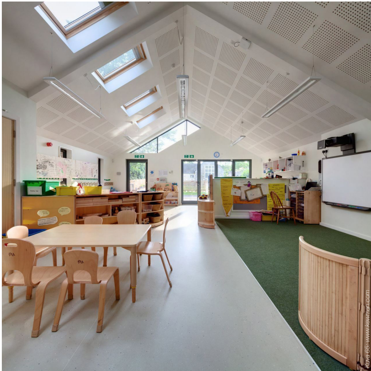
Luokkahuoneen sisäkatto on usein ainakin osin akustoiva.
