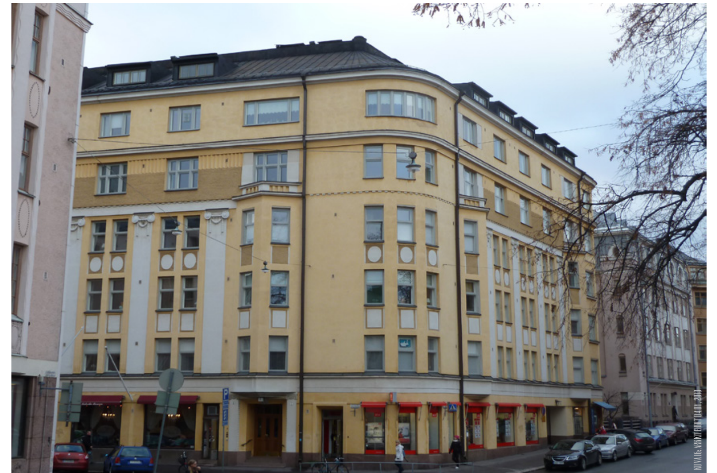
Julkisivuista käy ilmi että Cygnaeuksenkadulla olevassa kerrostalossa on rakennettu kattoikkunat, vuonna 2002 ja täten pyritään Museokadun tuleviin kattoikkunat tekemään samalla periaatteella.
