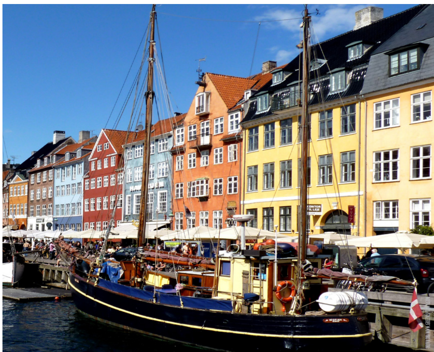
KUVA 38: Ullakkojulkisivu Kööpenhaminassa. Katukuva on hyvin erilainen ja värikäs mutta toimiva. Ullakkorakentaminen on hyvin runsasta Tanskassa ja ullakkoikkunoita näkyy melkein jokaisessa kadunvarressa. Näissä ei noudateta ns.linjakkuutta, vaan ikkunat rikastuttavat arkkitehtuuria erilaisilla ratkaisuilla.
