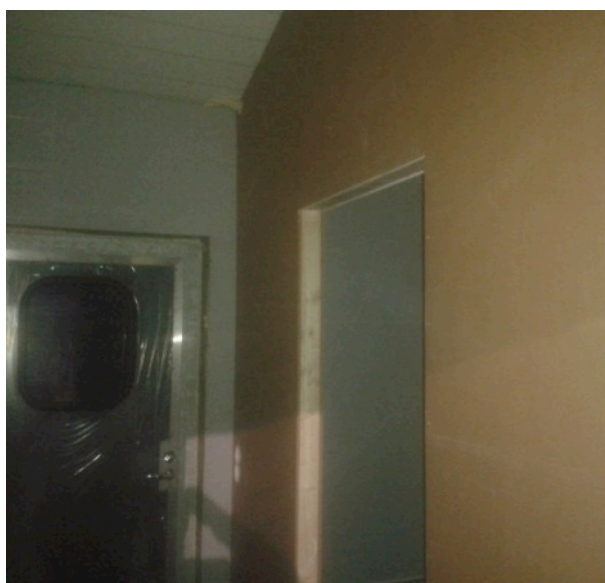
Figur 30 Spirad mellanvägg med gipsbeläggning. 3
