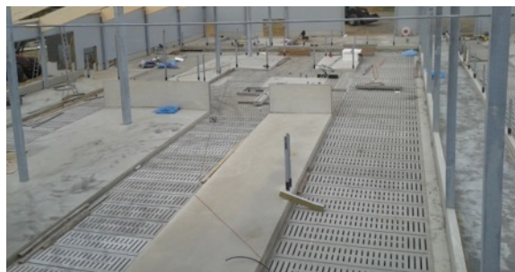
Figur 12 Ligg-yta efter gjutning. 3
