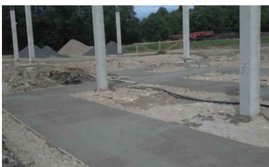
Figur 3 Kanalgolvs gjutning vid kanaler av betongblock. 3
