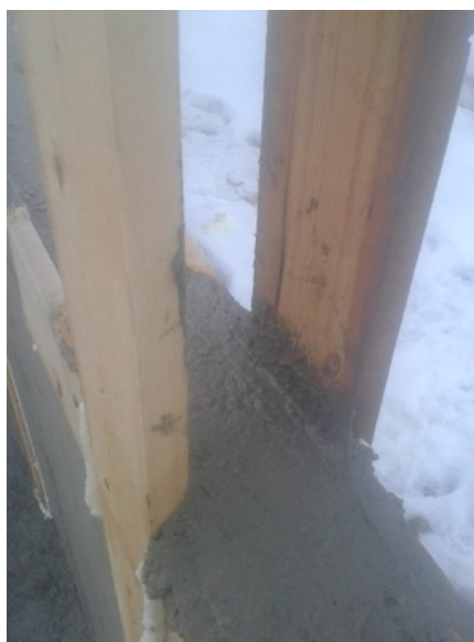
Figur 44 Närbild på gjuten fog sett uppifrån. 2
