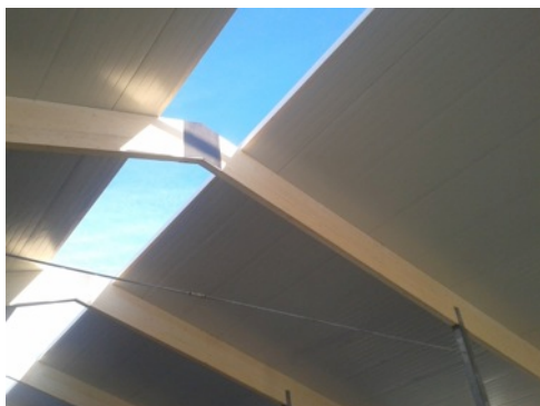
Figur 37 Takelement efter montering sett från insidan. 3
