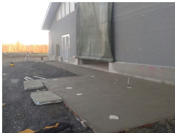
Figur 24 Ramp och silogrund efter gjutning. 2
