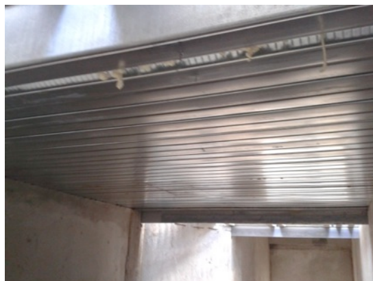
Figur 18 Valvgjutning sett underifrån med gjutplåt synlig. 2
