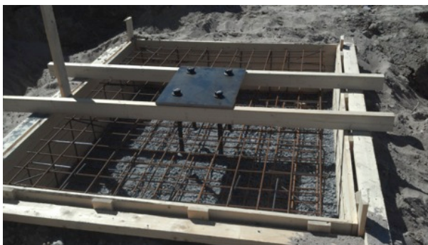
Figur 1 Pelargrundform, armering och bultsats före gjutning. 2
