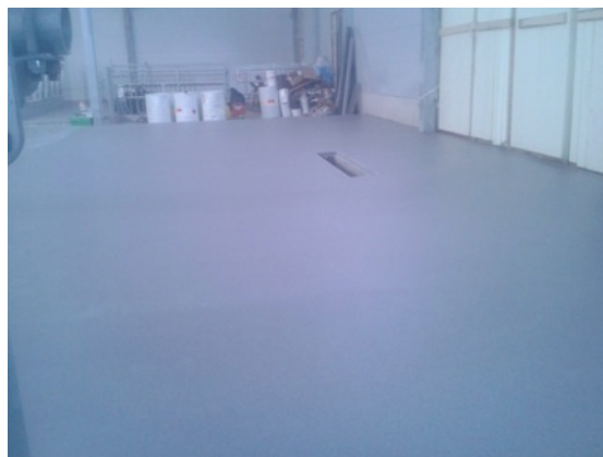
Figur 14 Foderrumsgolv efter akrylbehandling. 2
