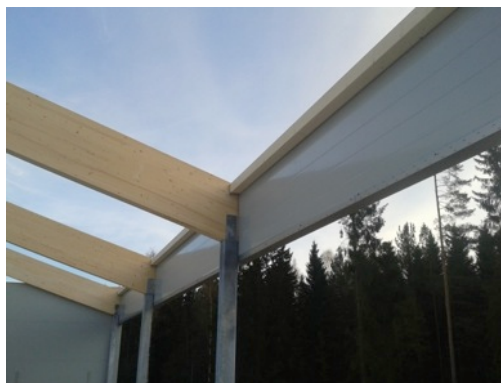
Figur 36 Limträbalkar för vindstabilitet i längdriktning monterade. 2
