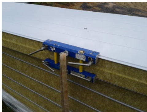
Figur 26 Lyftverktyg för montering av Paroc sandwich-element. 2
