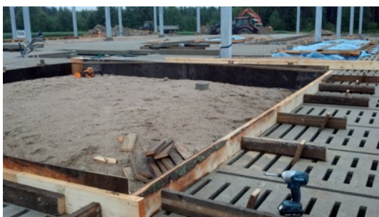
Figur 11 Ligg-yta i formningsskede. 3
