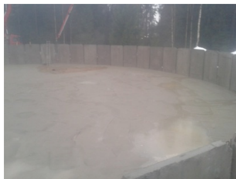
Figur 42 Brunnsbotten efter gjutning. 4
