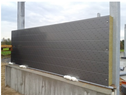
Figur 25 Paroc sandwich-element i monteringskedet. 2
