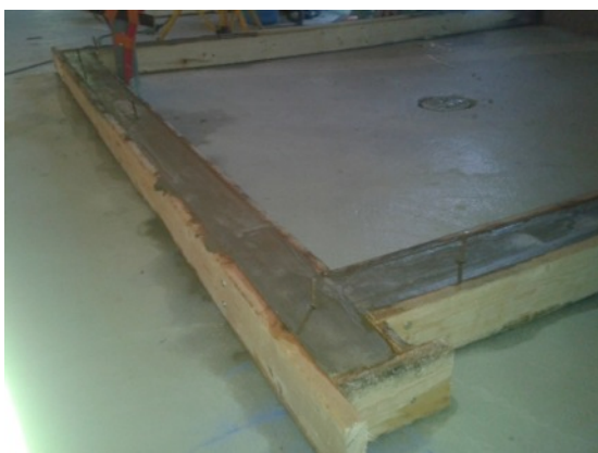
Figur 21 Gjutning av mellanväggsgrund. 2
