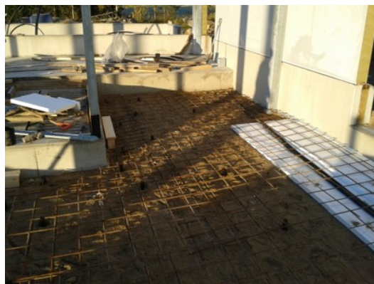
Figur 20 Ströbädd före gjutning. 2
