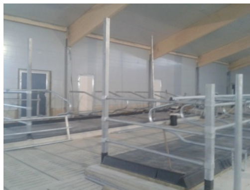
Figur 46 Båsinredning och grindar i monteringskede. 3
