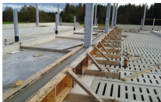
Figur 16 Foderbord, klövpall samt foderbordskant efter gjutning. 2
