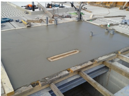
Figur 17 Robotrummets valvgjutning sett ovanifrån. 2
