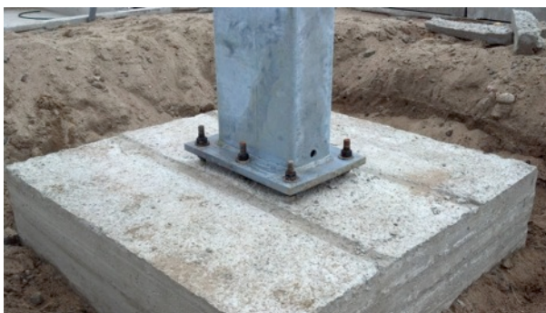
Figur 7 Stålpelare monterad på pelargrund med bultsats. 3
