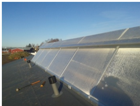
Figur 40 Takfönster efter montering. 3
