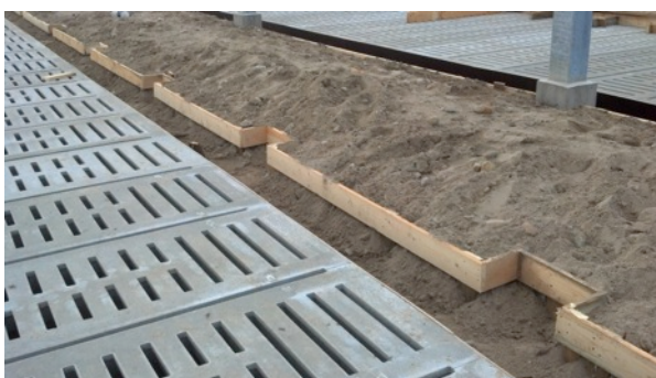
Figur 15 Exempel på formning av klövpall. 2
