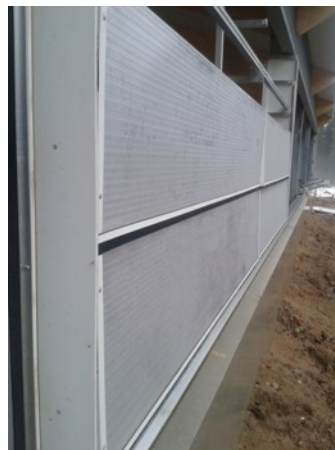
Figur 32 Spjälffönster i monteringskedet sett från utsidan. 2
