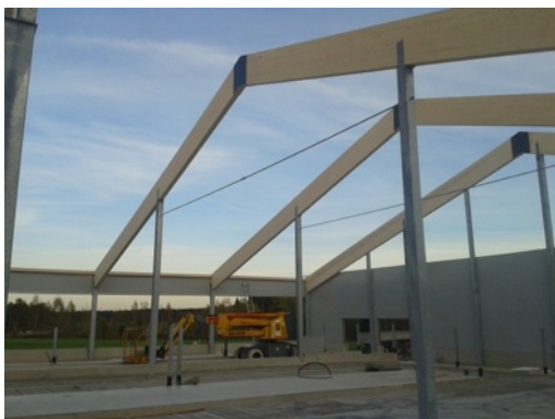
Figur 35 Dragstänger monterade. 2
