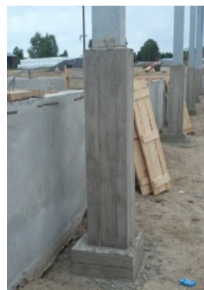
Figur 8 Exempel på skyddsgjutning för stålpelare. 3
