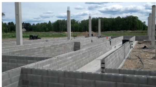
Figur 4 Exempel på flytgödselkanal av betongblock. 3
