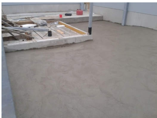
Figur 19 Ströbädd efter gjutning samt slipning. 2
