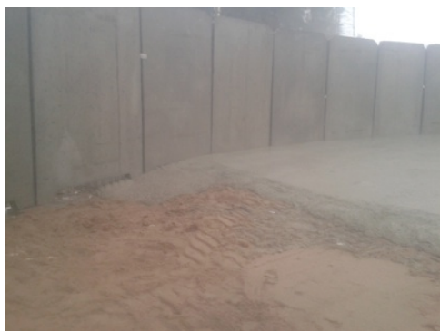
Figur 41 Gjutning av brunnsbotten. 4
