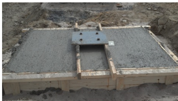
Figur 2 Pelargrundform med armering samt bultsats och svetsplatta efter gjutning. 2
