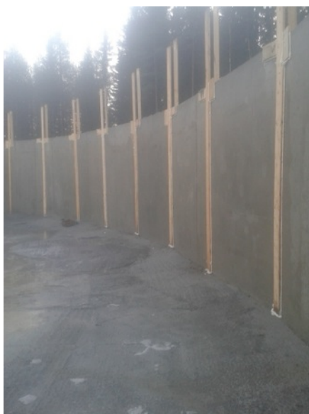
Figur 43 Formning av fogar. 2
