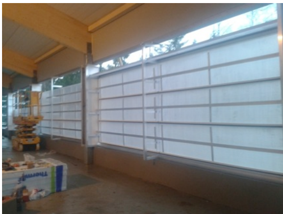
Figur 31 Spjälffönster i monteringskedet sett från insidan. 2
