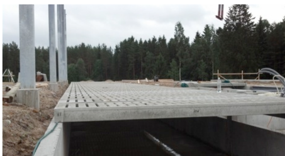
Figur 9 Betongspalter i monteringskedet. 2
