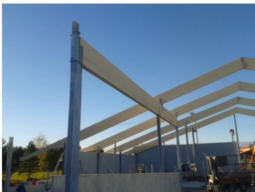
Figur 33 Takbalkar i monteringskedet. 2
