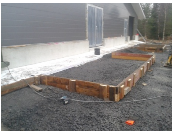
Figur 23 Ramp och silogrund i formningsskedet. 2
