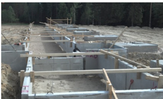
Figur 5 Exempel på flytgödselkanal av betongelement. 2
