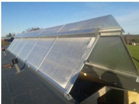
Figur 39 Takfönster i monteringskedet. 3
