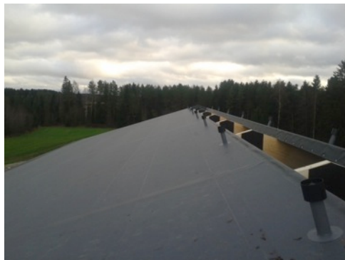
Figur 38 Takelement efter montering med ihop-svetsat ytterskikt sett från utsidan. 3
