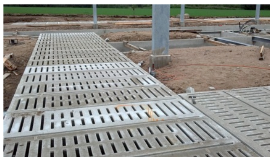
Figur 10 Betongspalter efter montering. 2
