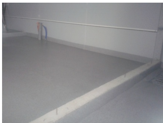
Figur 22 Golv samt mellanväggsgrund i sociala utrymmen efter akrylbehandling. 2
