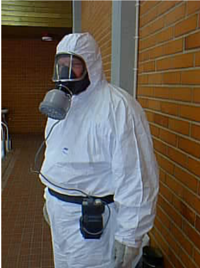
Kuva 21. Suojautuminen, kuten asbestipurkutöissä. [23]
