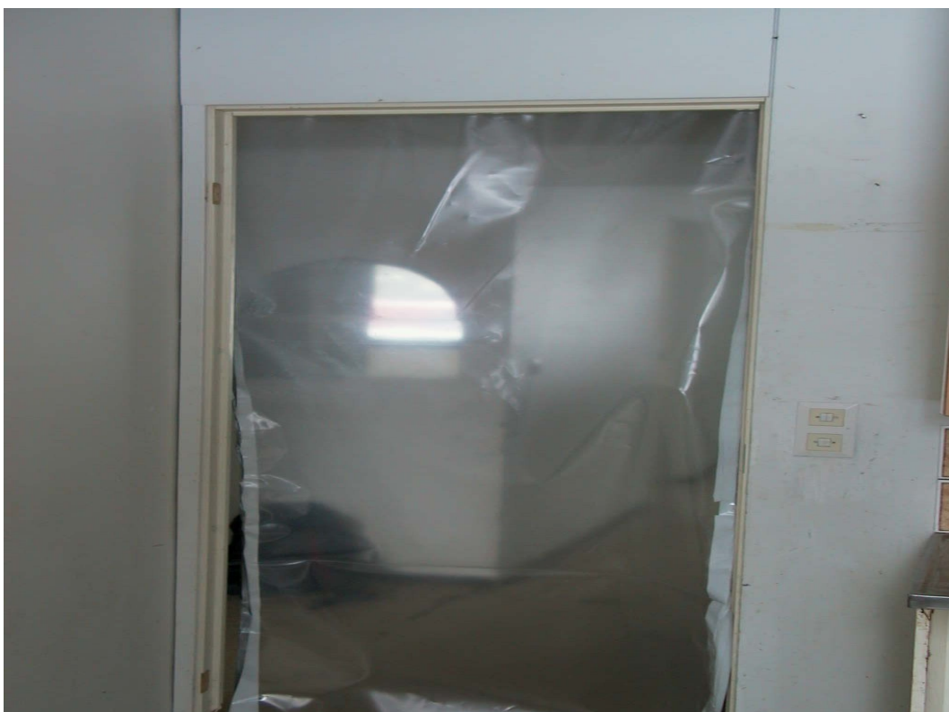
Kuva 15. Oviaukko muovilla suljettuna.
