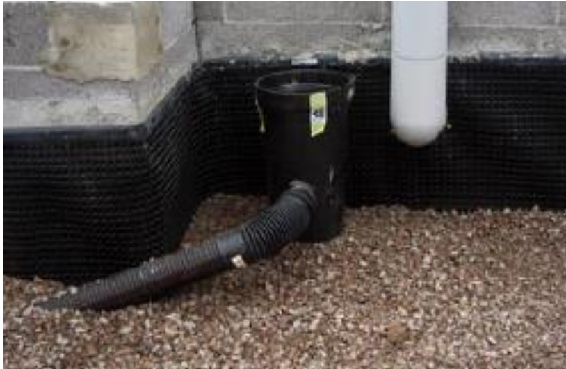
Kuva 19. Sakkapesällinen sadevesikaivo ja sadevesiviemäri. [24, s. 34.]
