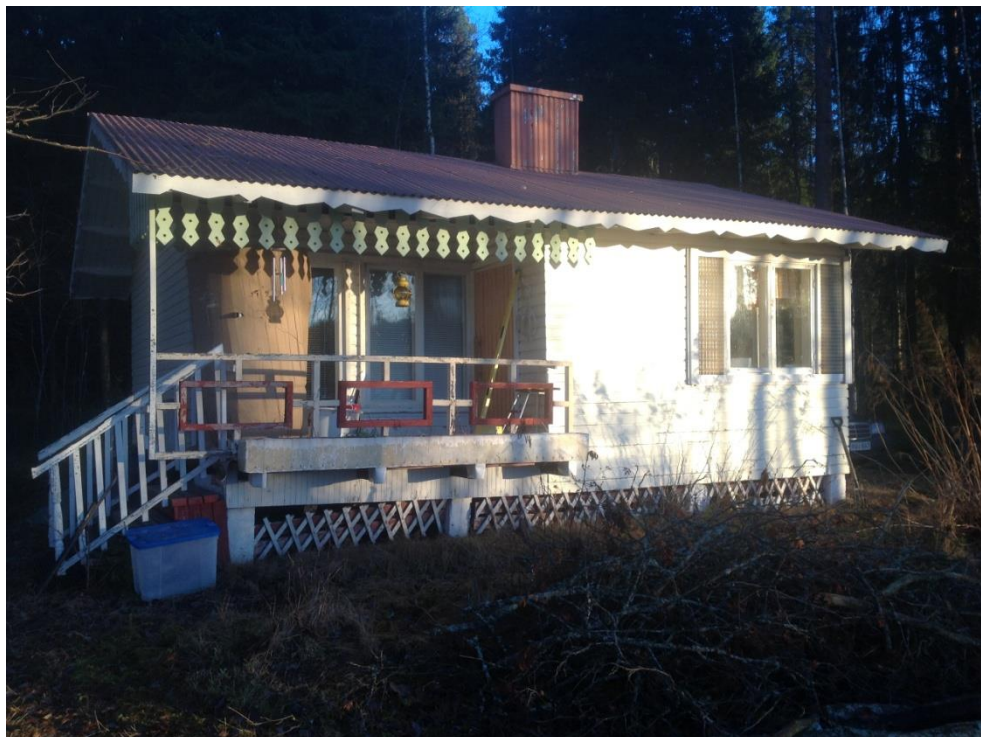
Kuva 1. Alkuperäinen päärakennus järveltä katsottuna.
