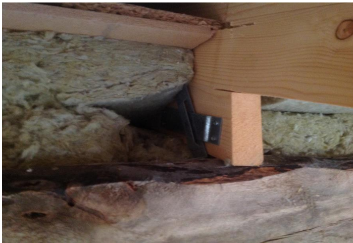
Kuva 20. Kattokannattajan liitos seinärakenteeseen.
