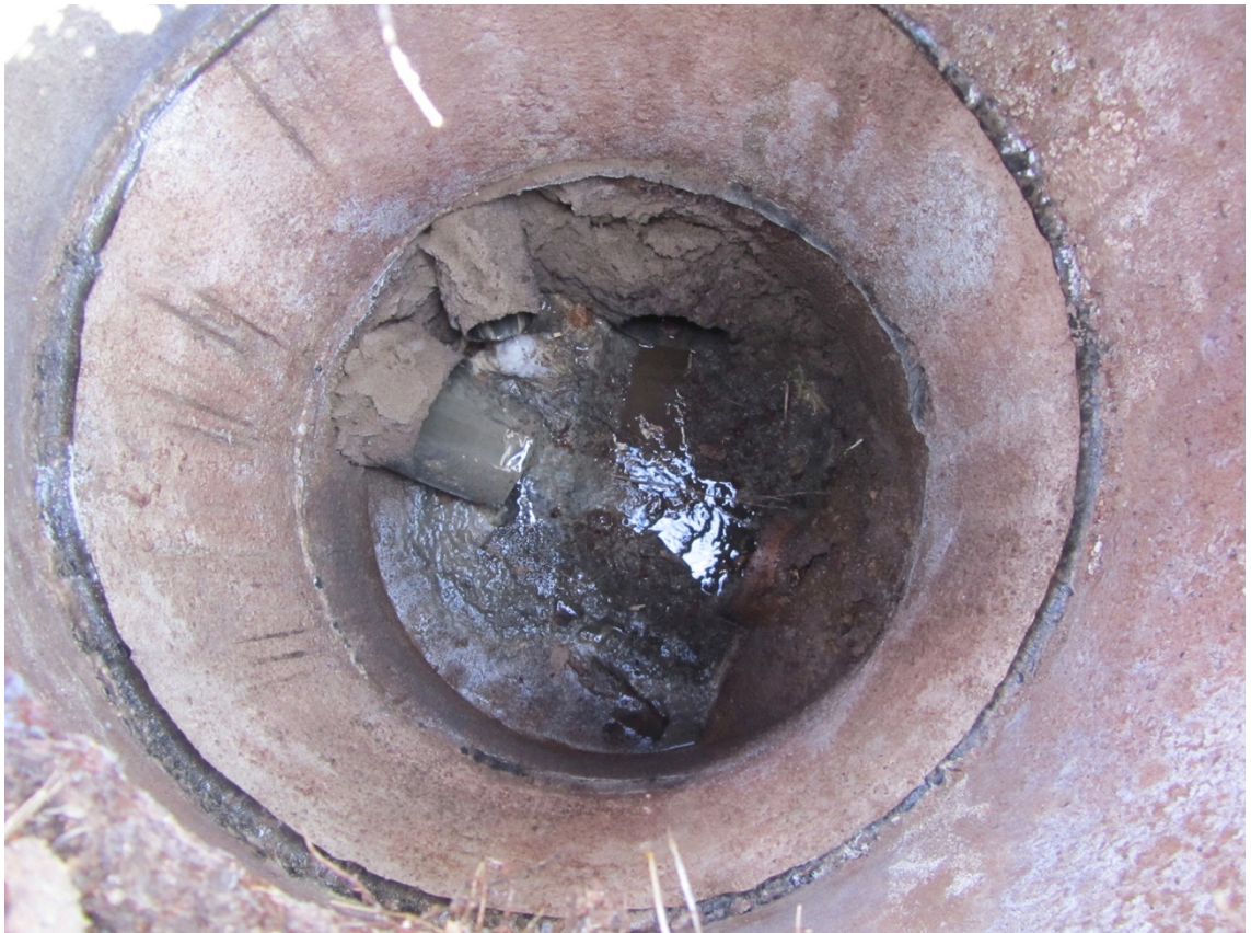
KUVA 11. Maa-ainesta Niemeläntien tarkastuskaivossa (Henkilökohtainen tiedonanto 2013)
