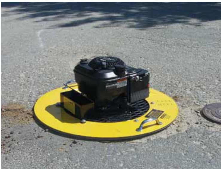
KUVA 6. Savupuhallin (FCG, savukoe )
