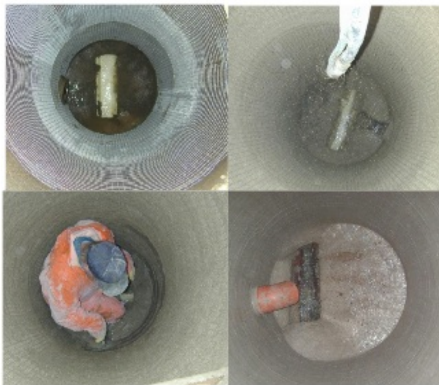
Kuva 23. Kaivon ruiskubetonointi (Putkistojen kaivamattomat saneerausmenetelmät, FiSTT 2010)
