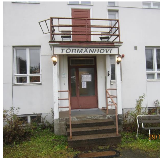
KUVA10. Betonipilareilla tuettu parveke
