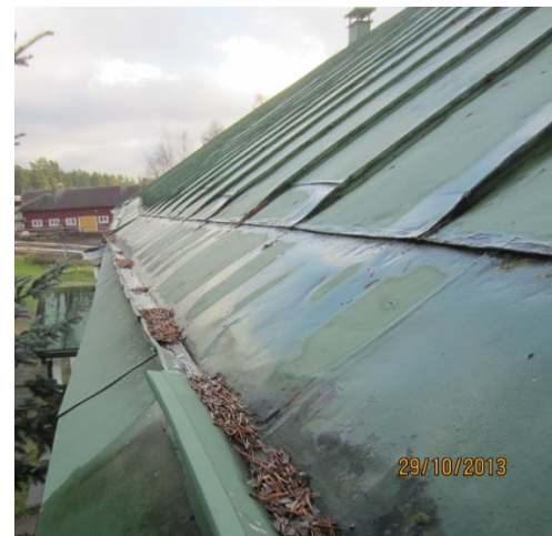
KUVA4. Rakennuksessa on jalkärännit
