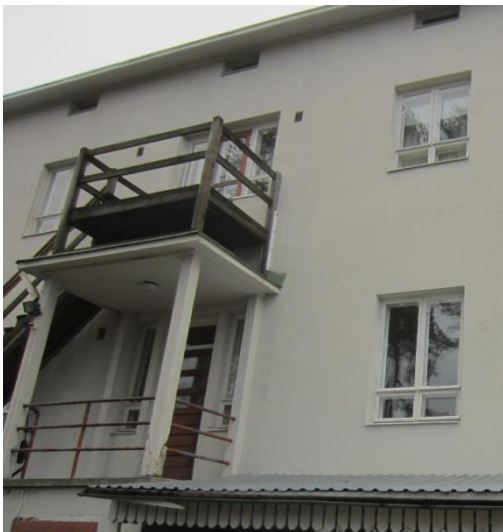
KUVA9. Parveke, joka on tarkoitettu hätäpoistumistieksi
