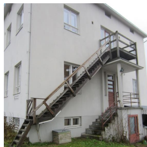
KUVA6. Häätäpoistumistie toisesta kerroksesta
