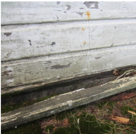
KUVA 20. Alin hirsi on kastunut huonon tuuletuksen ja maanpinnan väärin kallistusten vuoksi (kuva myös liitteessä 1)
