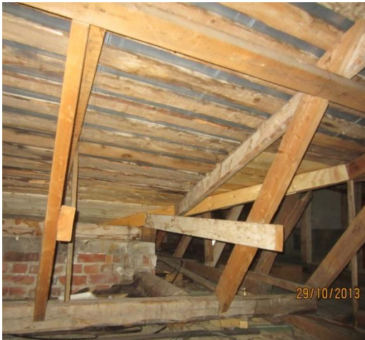
KUVA25. Uuden osan puurakenteiden yläpohja
