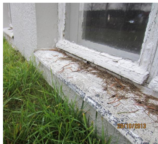
KUVA36. Vesipenkkipellin kallistus on väärään suuntaan
