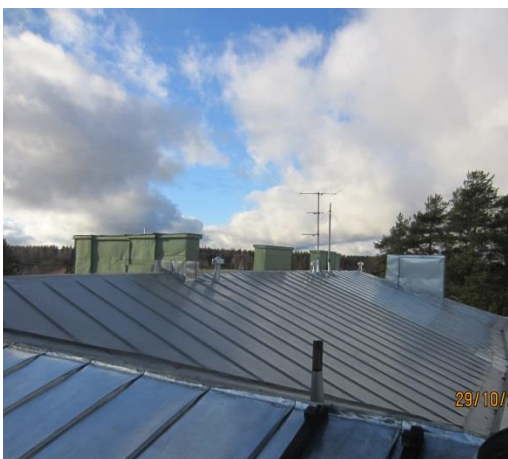
KUVA21. Uuden osan konesaumattu peltikatto
