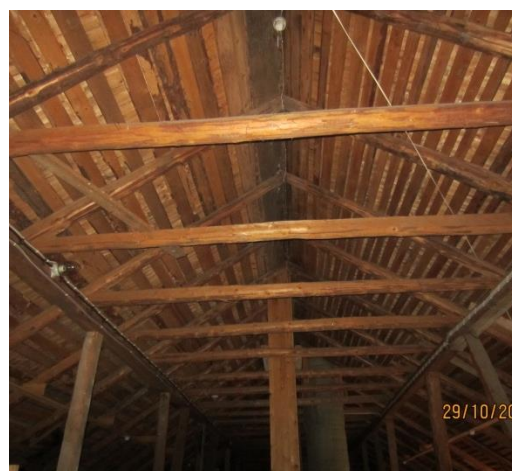
KUVA24. Vanhan osan puurakenteinen yläpohja
