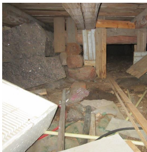
KUVA16. Porakivien ja puupylväiden varaan rakennettu tuulettuva alapohja
