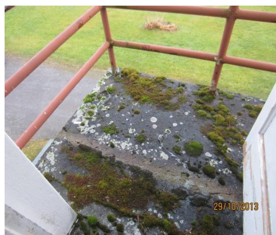
KUVA12. Ulokeparvekkeella kasvaa sammalta ja pinnassa on halkeamia
