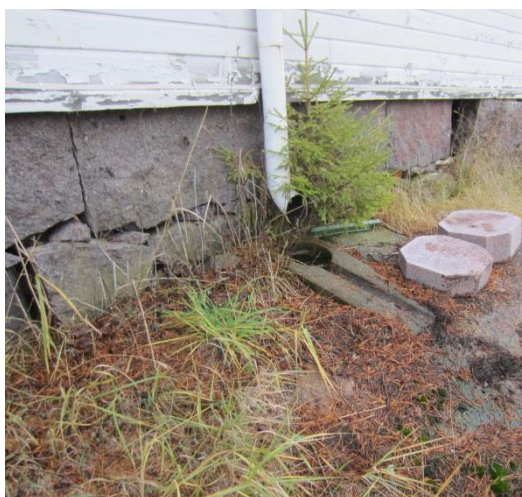
KUVA15. Vanhalla osalla on porakiviviperustus
