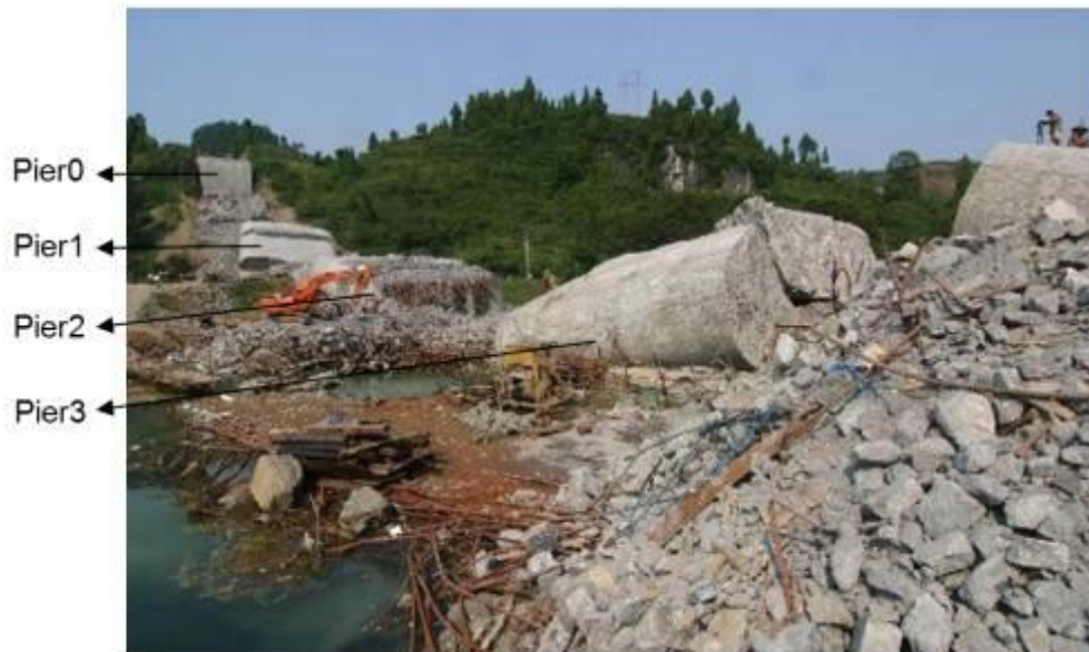
Kuva 8. Valokuva kivikaarisillasta sortumisen jälkeen. (Xu, Lu, Guan, Lu, A. Ren 2013)
