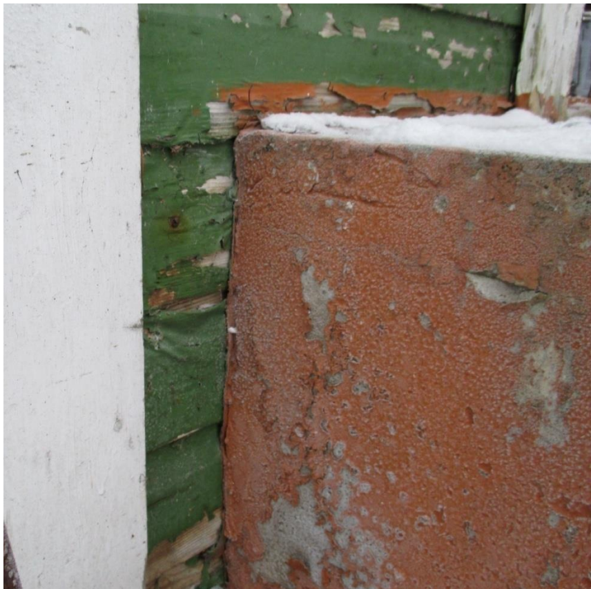
Kuva 6. Kylmäeteisen betoniportaat. Kuva: Arttu Pitkänen 2013
