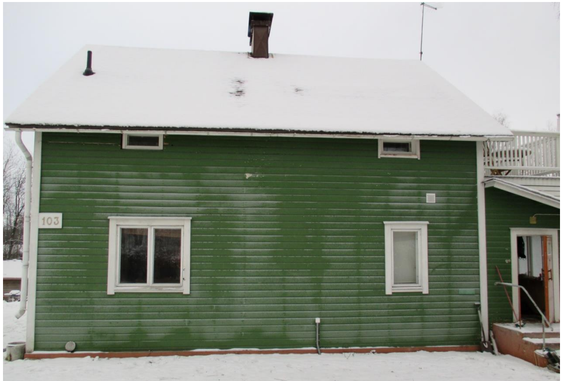
Kuva2. Näkymä rakennuksen pohjoispuolelta. Kuva: Arttu Pitkänen 2013
