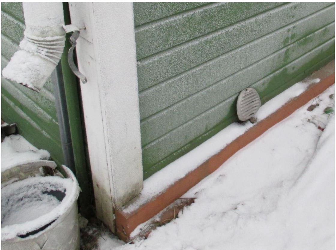
Kuva 4. Sokkeli valettu paneelin päälle. Kuva: Arttu Pitkänen 2013
