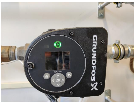
Kuva 1. Magna3 kiertovesipumppu. (Kuva: Visa Westerlund)
