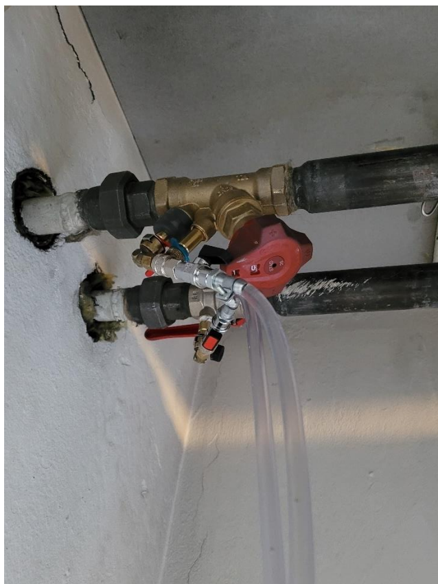
Kuva 11. U-manometri yhdistettynä mittayhteisiin. (Kuva: Visa Westerlund)
