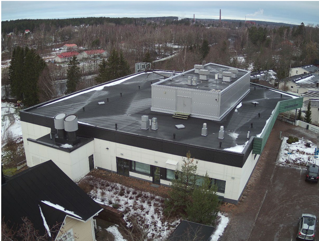
Kuva 1: Ilmakuva Karhulan uimahallista, missä näkyvät katolla sijaitsevat ilmanvaihdon ulospuhallushajottimet. Kuvaaja Jani Piispa, Aeria, 2021
