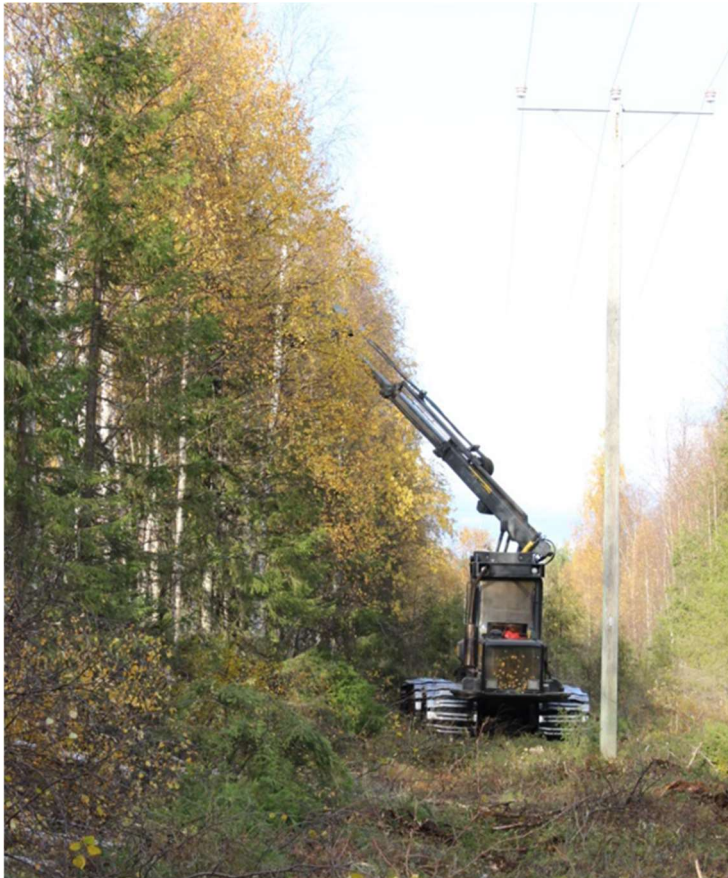
Kuva 6. Koneellista linja-aukon raivausta 20kV linjalla (Koillis-Lapin Sähkö Oy 2022a)
