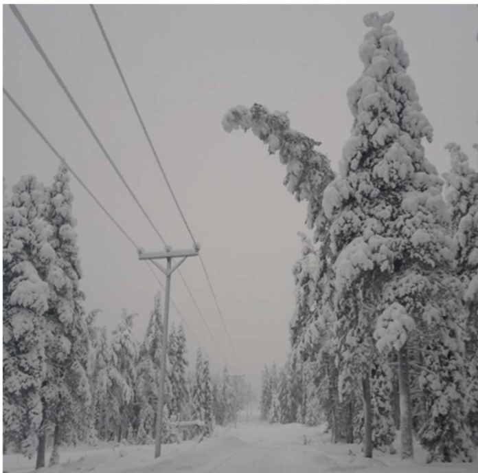
Kuva 5. Talvella 2021-2022 Tykyn seurauksena puu kaatumassa 20 kV linjalle (Koillis-Lapin Sähkö Oy 2022a)
