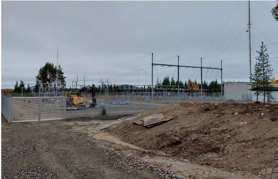
Kuva 4. Isokeron sähköasema. Rakenteilla uusi 110 kV lähtö Kellarijängän sähköaseman suuntaan.
