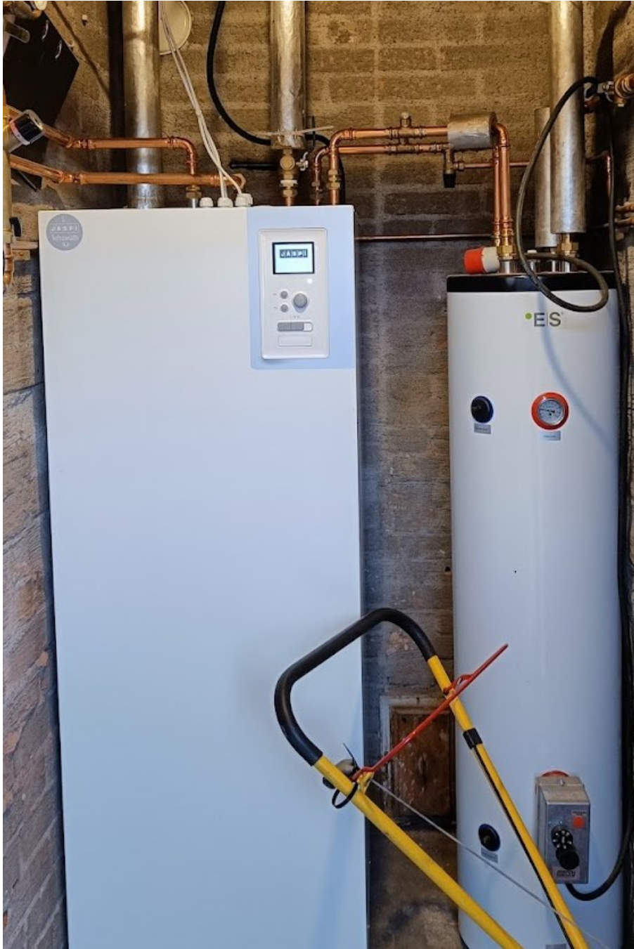
Kuva 14. Ilma-vesilämpöpumppu ja puskurivaraaja asennettuna öljykattilan tilalle.
