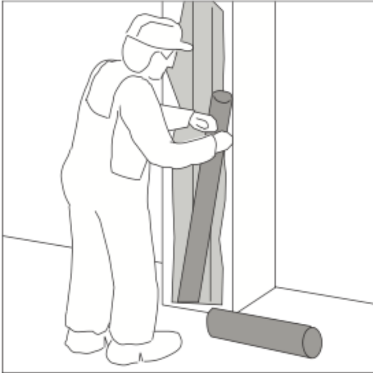
KUVA 1. Vanhojen linjojen purkaminen hormista (2, s. 8)
