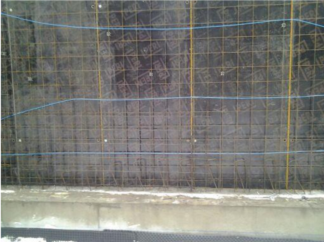
KUVA 9. Sisäkuoren sisin muottipinta, sekä raudoitus ja lämmityskaapelit.
