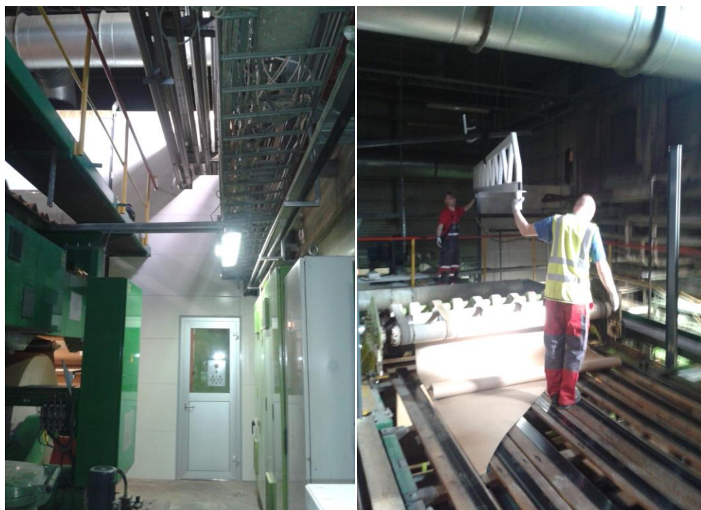
Kuva 10. Vasemmalla elementtien loveaminen rakenteiden ympärille ja oikealla kattoristikoiden asentaminen paikalleen.
