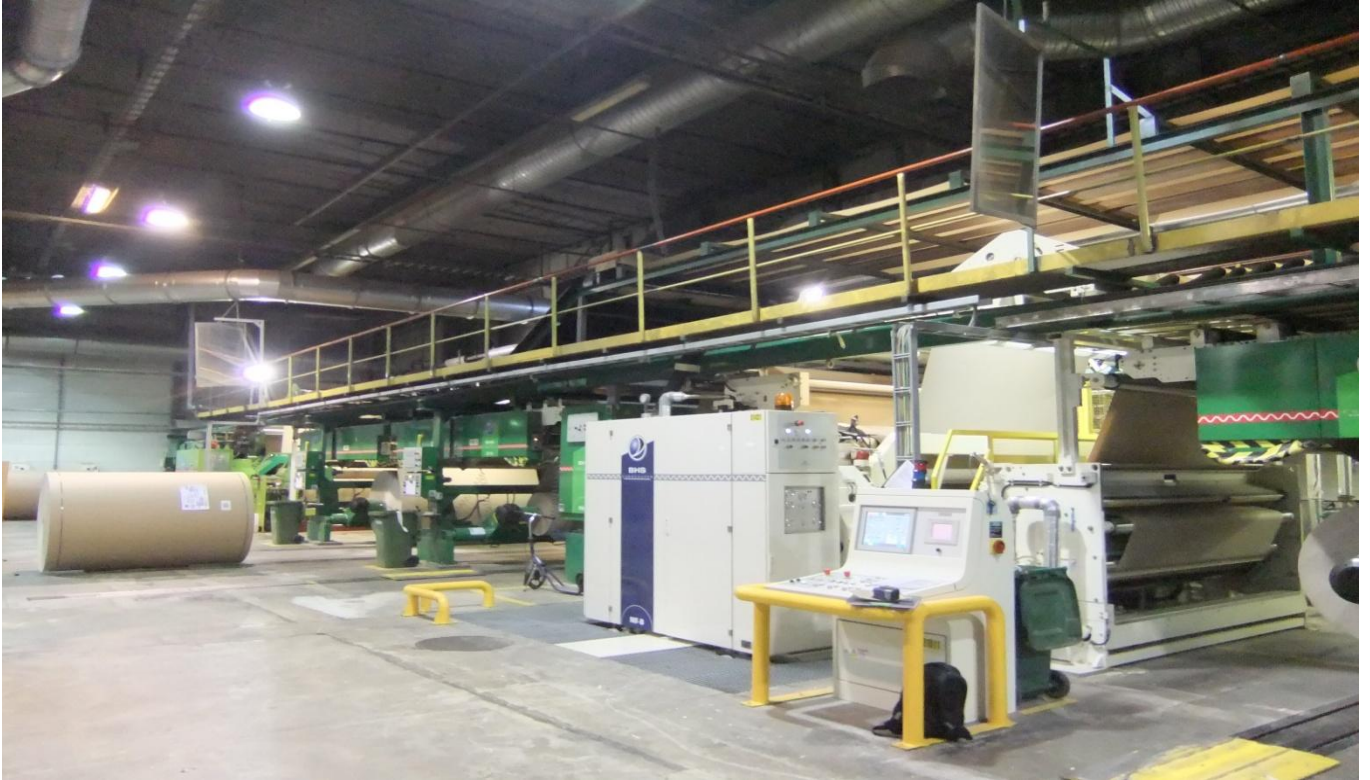
Kuva 12. Aallottajakoneet 1 ja 2 ennen asennuksen aloitusta.
