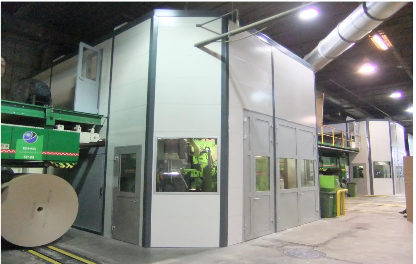
Kuva 13. Koneet suojatilojen asennuksen jälkeen.
