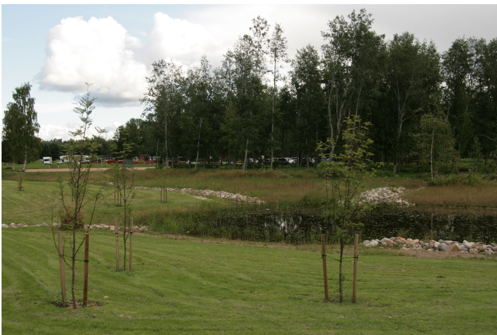
Kuva 2: Hulevesilammikko viivyttämässä vesien pääsyä mereen Kokkolassa (Kallio 2011)
