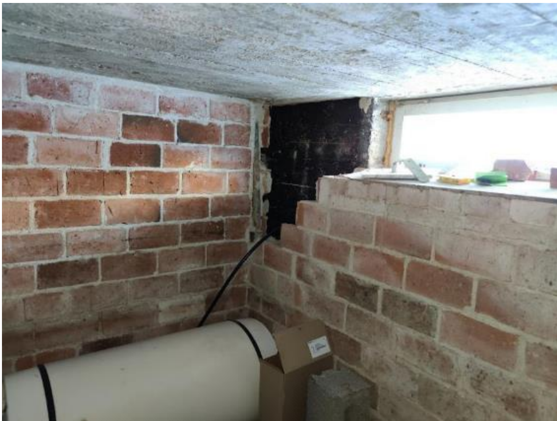
Kuva 12 Kellarin seinän kuorimuuraus osittain purettu.
