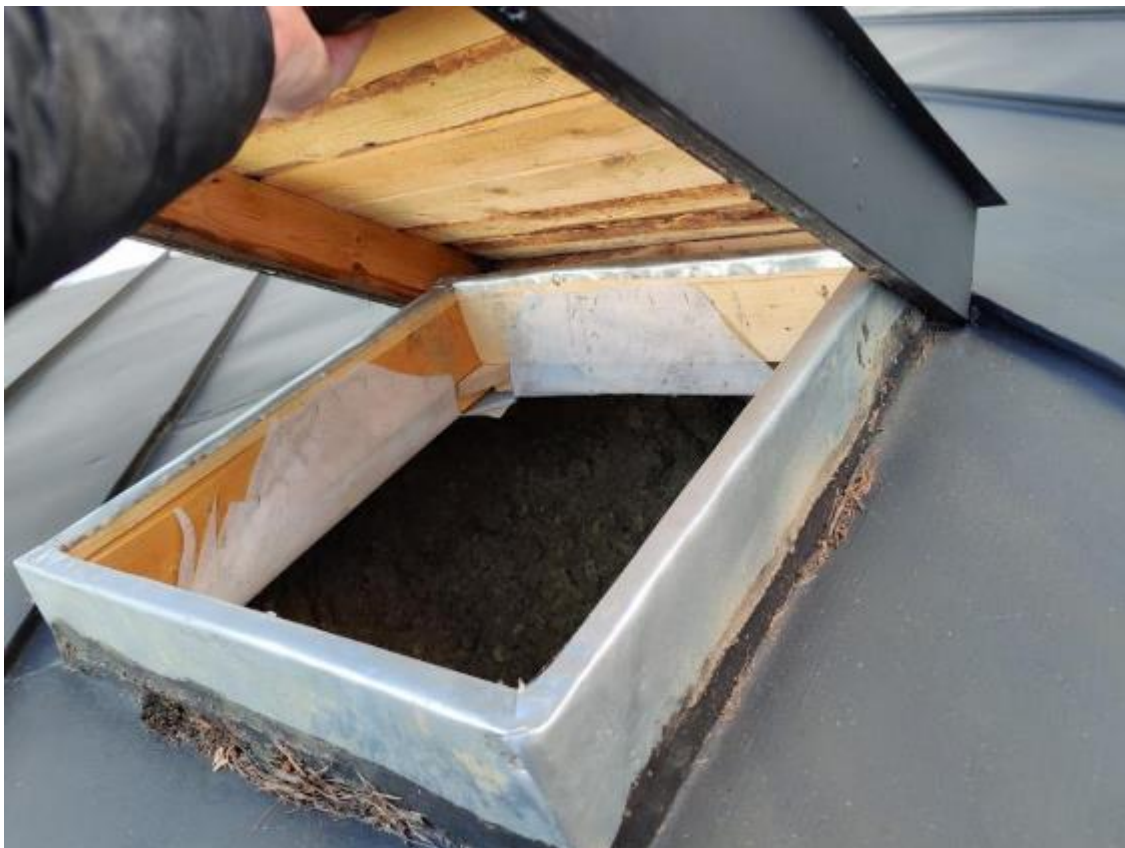
Kuva 25 Yläpohjan kunto tarkastettiin päärakennuksen kattoluukun kautta
