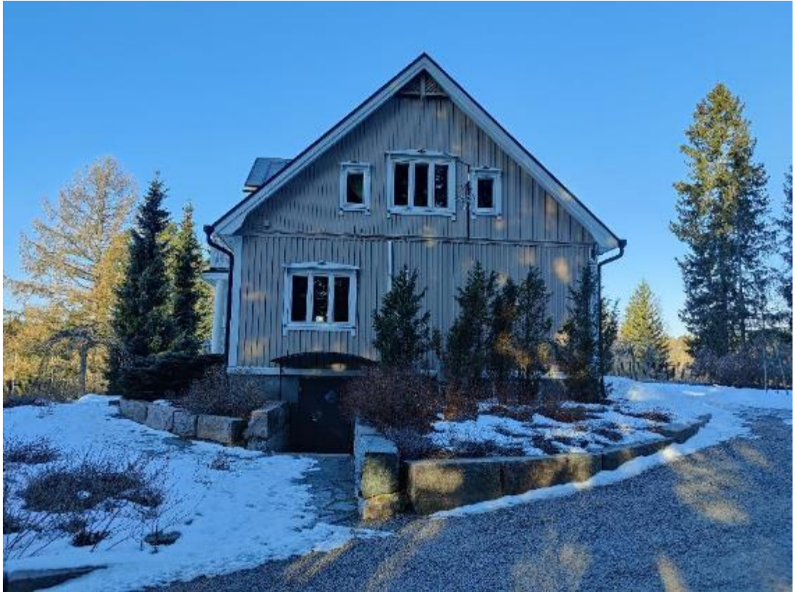
Kuva 15 Päärakennuksen päädystä puuttuu hätäpoistumistikkaat
