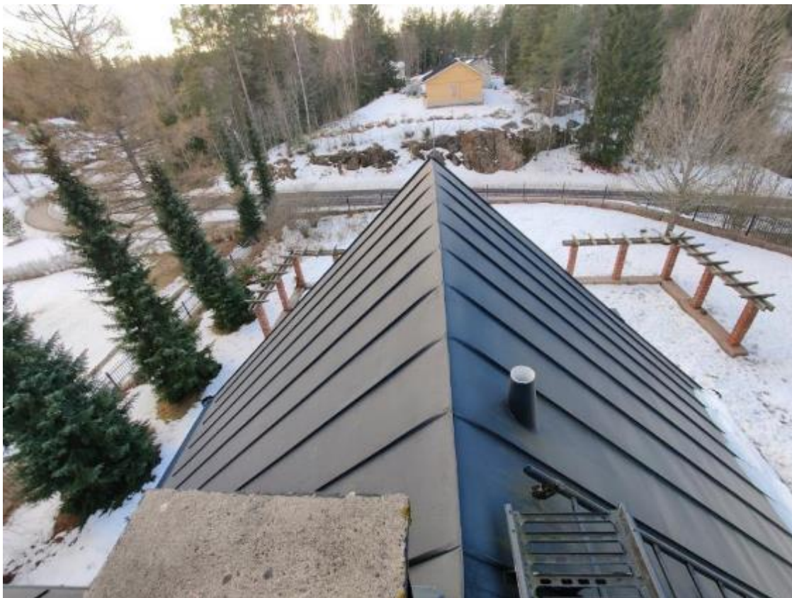
Kuva 24 Yleiskuvaa päärakennuksen harjalta. Katon yleisilme siisti
