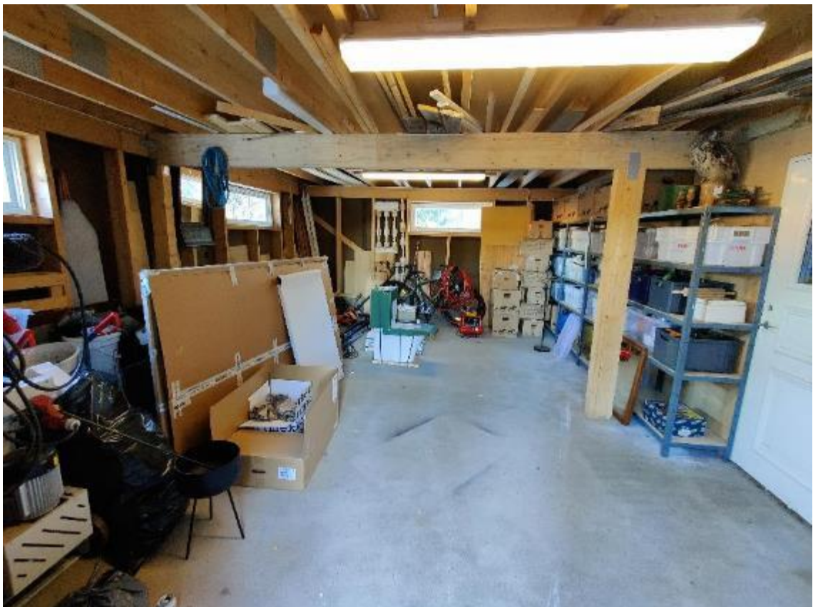
Kuva 14 Talousrakennuksen pilari-palkkirunko kuvattuna
