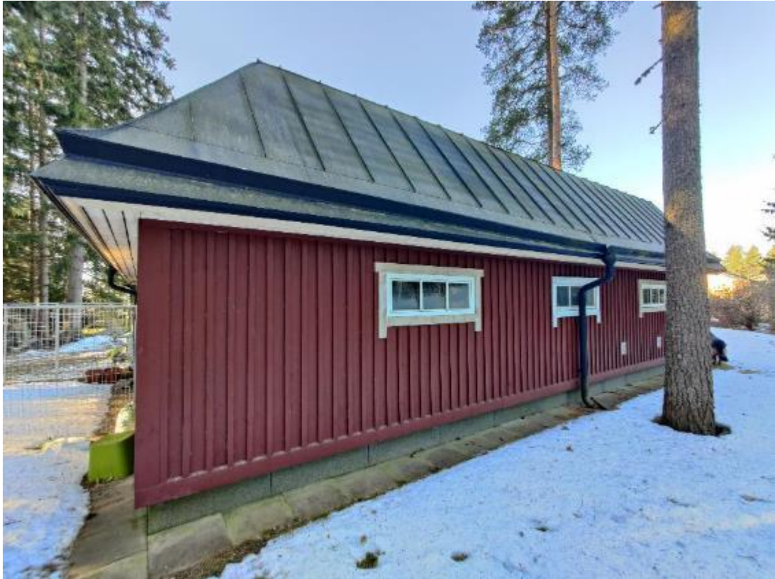
Kuva 27 Talousrakennuksen vesikaton kunto muuten siisti
