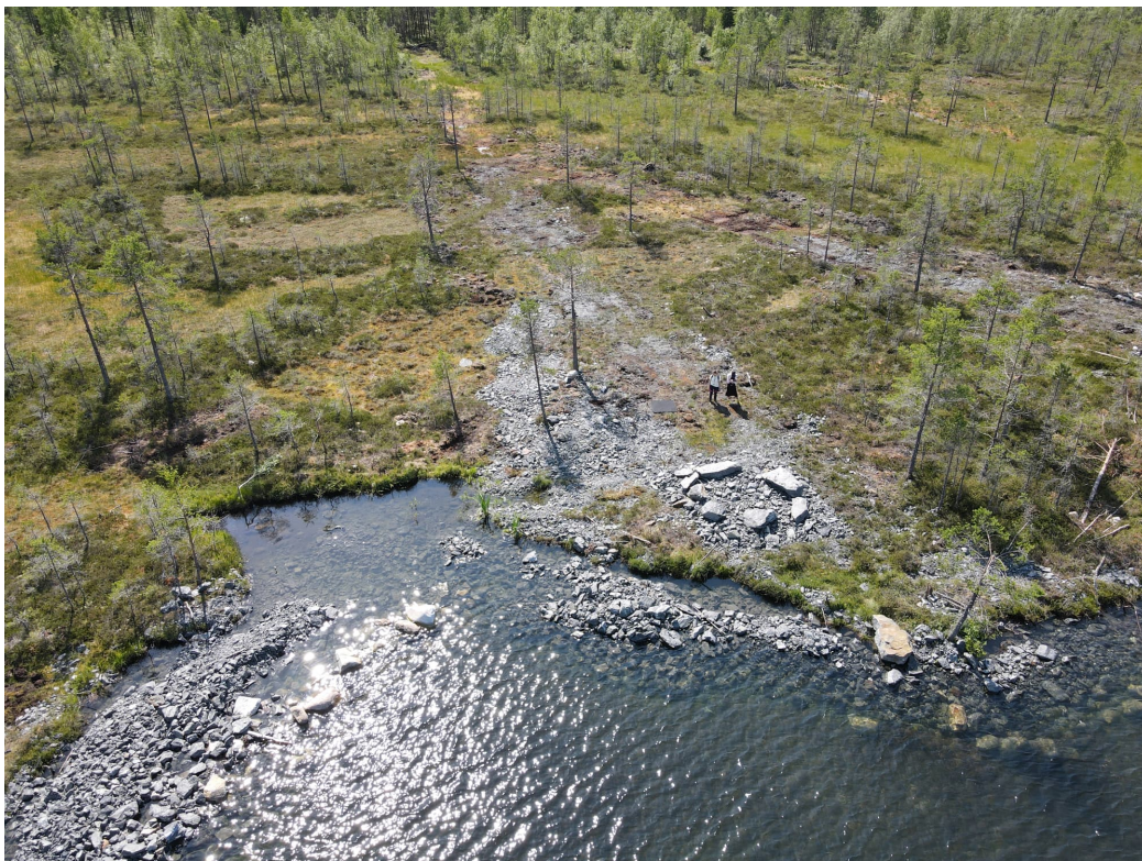
Kuva 12. Isojoen kunnassa sijaitsevan Kangasjärven vesirajalle rakennettu eroosiosuoja vuodelta 2022.
