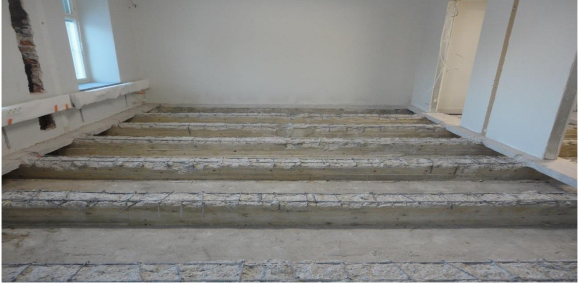
Kuva 21. Puretun pintalaatan alla olevat betonoidut I-palkit. 2. kerroksen lattia.
