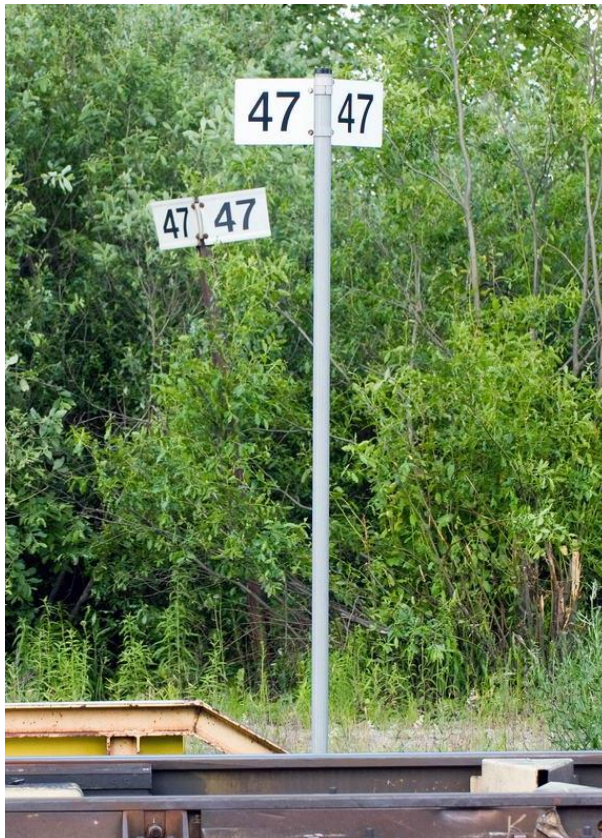
Kuva 8. Kilometrimerkit 47. Taaempänä näkyvä merkki on jäänyt ratalinjaukseen tehtyjen muutosten vuoksi hieman sivuun ja tämän vuoksi lähemmäs raidetta on asennettu uusi. Kuva on havainnollisuuden vuoksi otettu siten, että molemmat merkit näkyvät, eikä kohtisuorasti pituusmittausraiteeseen nähden, jolloin etualalla oleva merkki ei peittäisi taaempaa.
