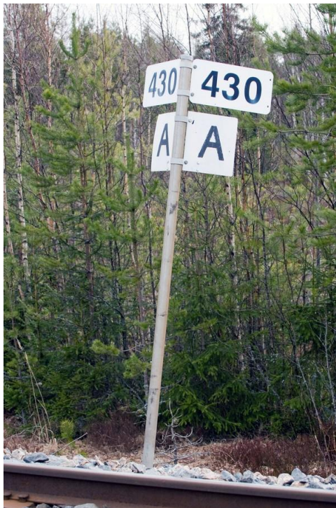
Kuva 15. Ratakilometriä 430A osoittava kilometrimerkki. Lisämerkintä ”A” on jouduttu lisäämään ratalinjauksen muuttumisen yhteydessä tapahtuneen linjauksen pidentymisen vuoksi. Edeltävä ratakilometri on 430 ja seuraava 431.
