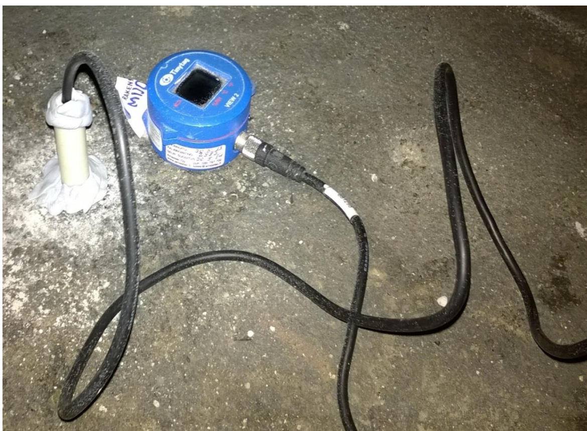
Kuva 7. Suhteellisen kosteuden (RH%) mittaus porareistä käynnissä. (Kuva: Ville Taskinen)
