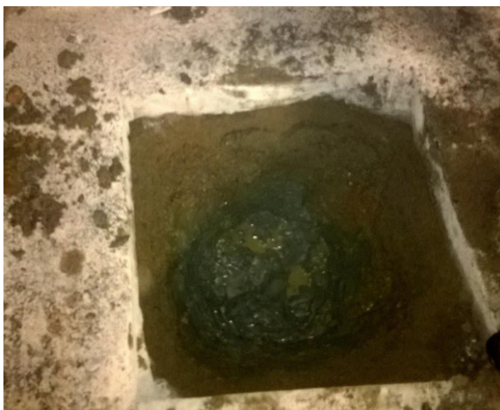
Kuva 11. Kaivanto valmiina. (Kuva: Ville Taskinen)
