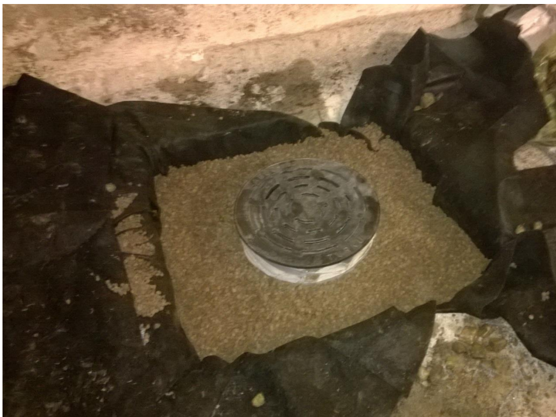
Kuva 13. Kaivo asennettuna. (Kuva: Ville Taskinen)
