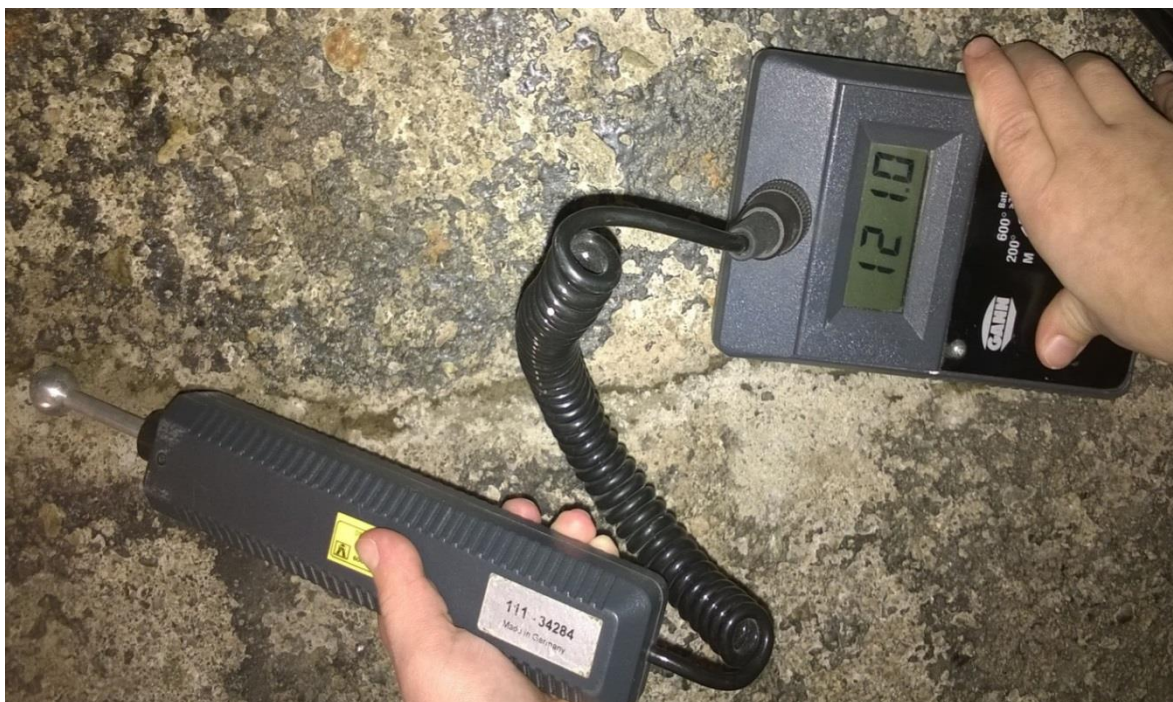
Kuva 6. Porareikämittauspaikan etsintä pintakosteusmittarilla. (Kuva: Ville Taskinen)
