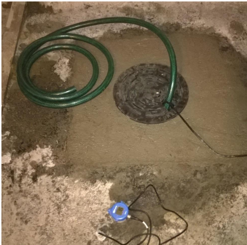
Kuva 16. Lattia valettu ja pumppu asennettu. (Kuva: Ville Taskinen)
