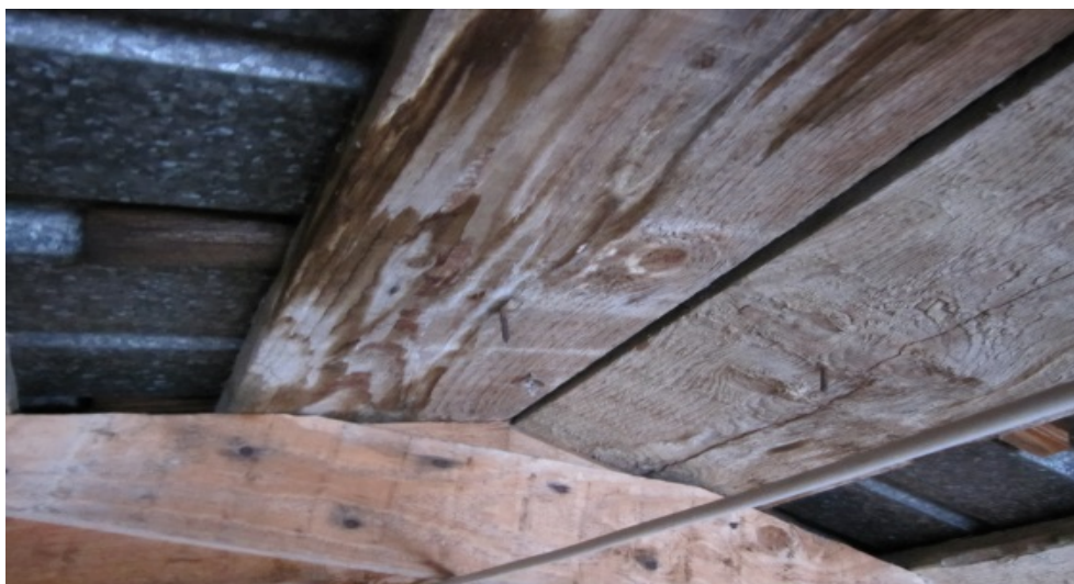
KUVA 3. Aluskatteeton kattorakenne (Talja 2014-02-25)
