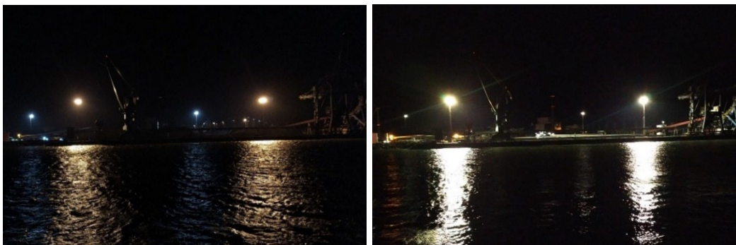
Kuvat 14. ja 15. Tahkoluodon laituri, vasemmalla vanhoilla ja oikealla uusilla valoilla.
