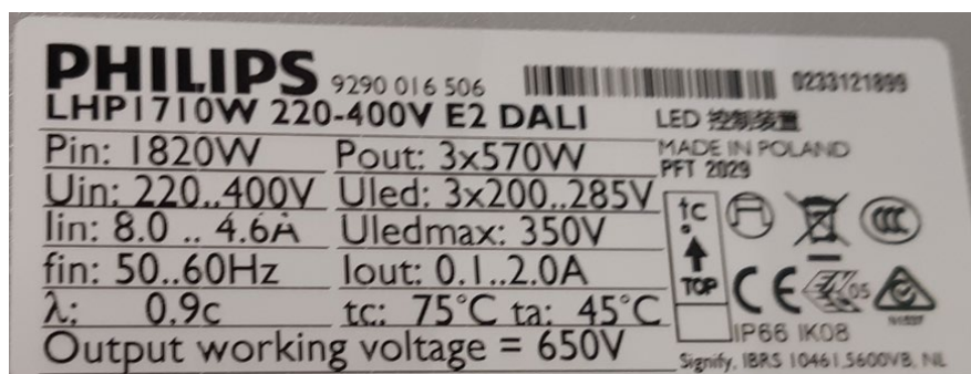
Kuva 9. Liitäntälaitteen tyyppikilpi (Aaltonen 2020)
