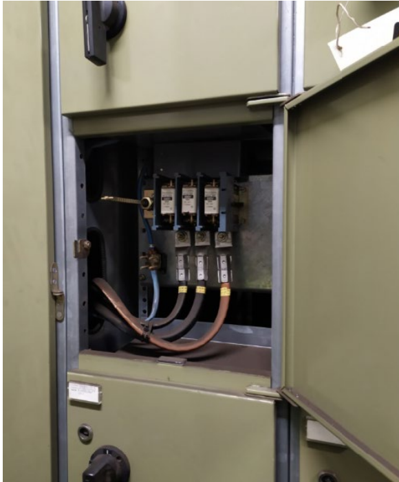
Kuva 12. Erään valoryhmän syöttö ja sulakkeet 100A
