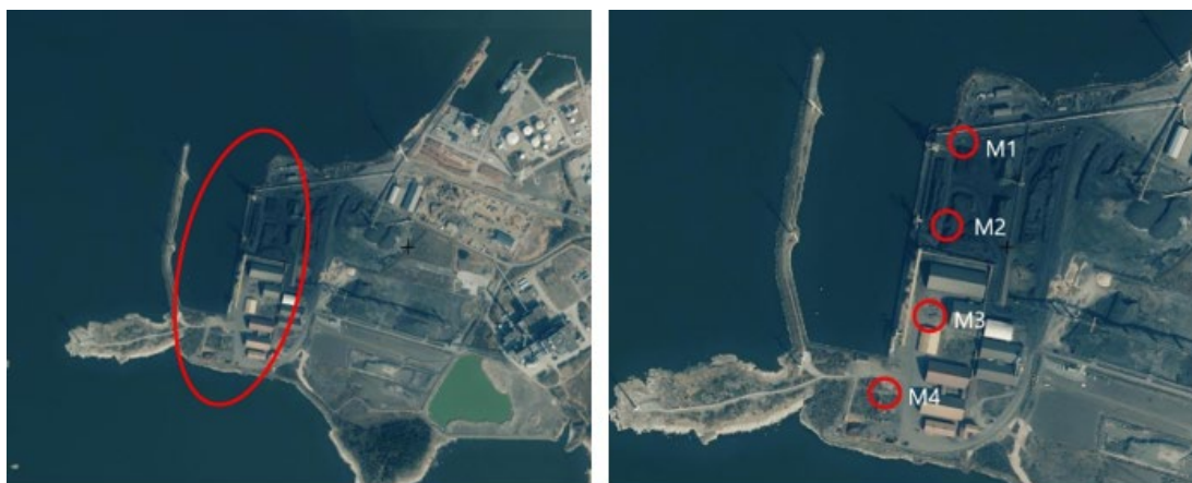
Kuvat 1 ja 2. Porin Tahkoluodon syväsataman alueen yleiskuva ja valaisinmastojen sijainti tarkemmin ja numeroituna (Karttapaikka 2019).
