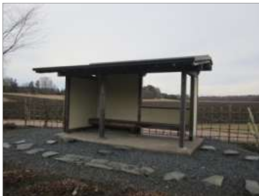
Kuva 33. Teepuutarhaosan odotushuone tehtiin lehtikuusesta. Rakenne on kestänyt hy- vin Suomen olosuhteissa. (Tuominen 2014.)
