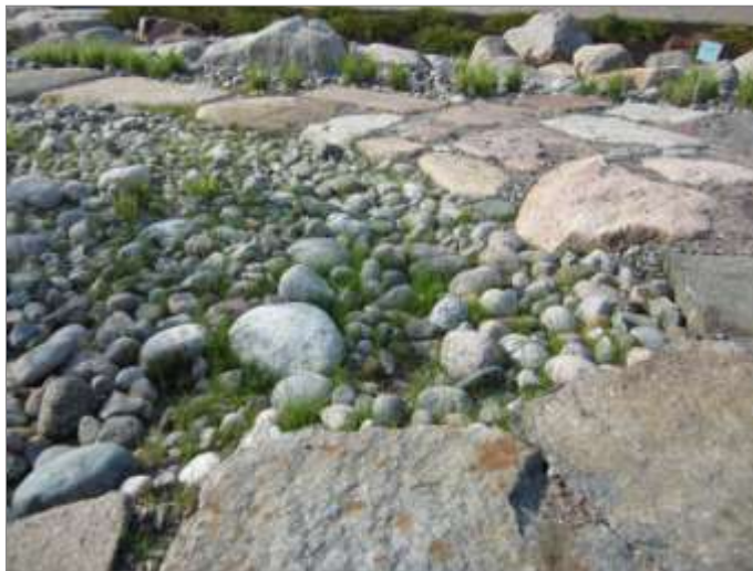
Kuva 47. Kivien välissä kasvava nurmikko on peräisin rinteestä, josta se valui kivien joukkoon vuoden 2013 rankkasateiden mukana. (Tuominen 2014.)
