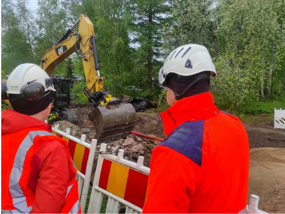
Kuva 1. PUMA-hanke vieraili maanrakennuskohteella Kajaanissa. Kuva: Ella Lukkari
