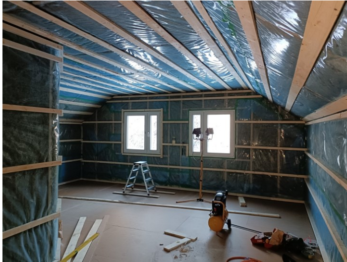
KUVA 4. Höyrynsulkumuovi ja koolauslaudat
