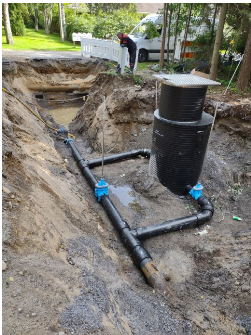
Kuva 4. aluemittaus kaivon asennus
