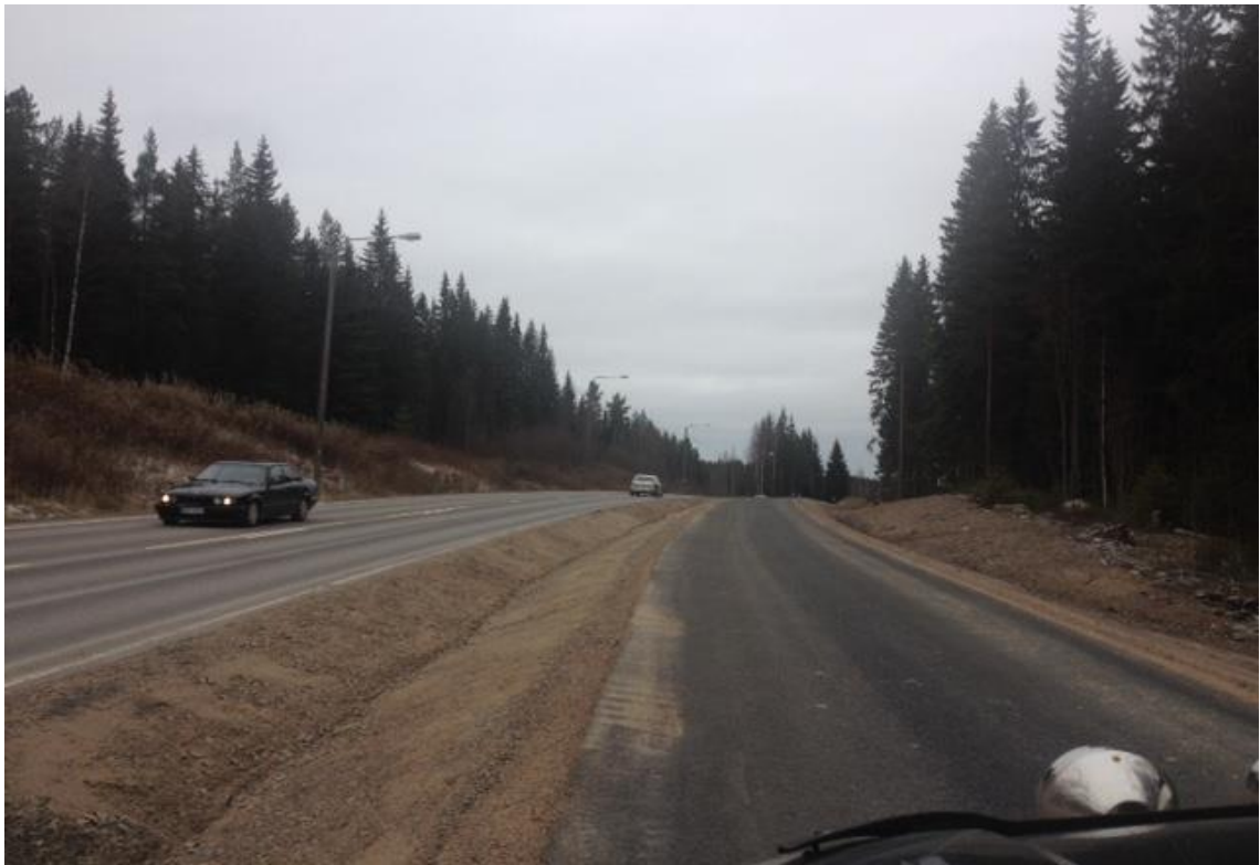
KUVA 17. Valmis rakenne Laajavuoressa. (Kuva: Arto Hyvärinen 2014).
