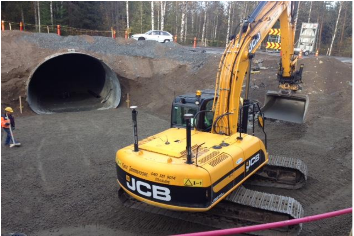
KUVA 13. S3 Siltajatkoksen pohjien tekoa. (Kuva: Arto Hyvärinen 2014).
