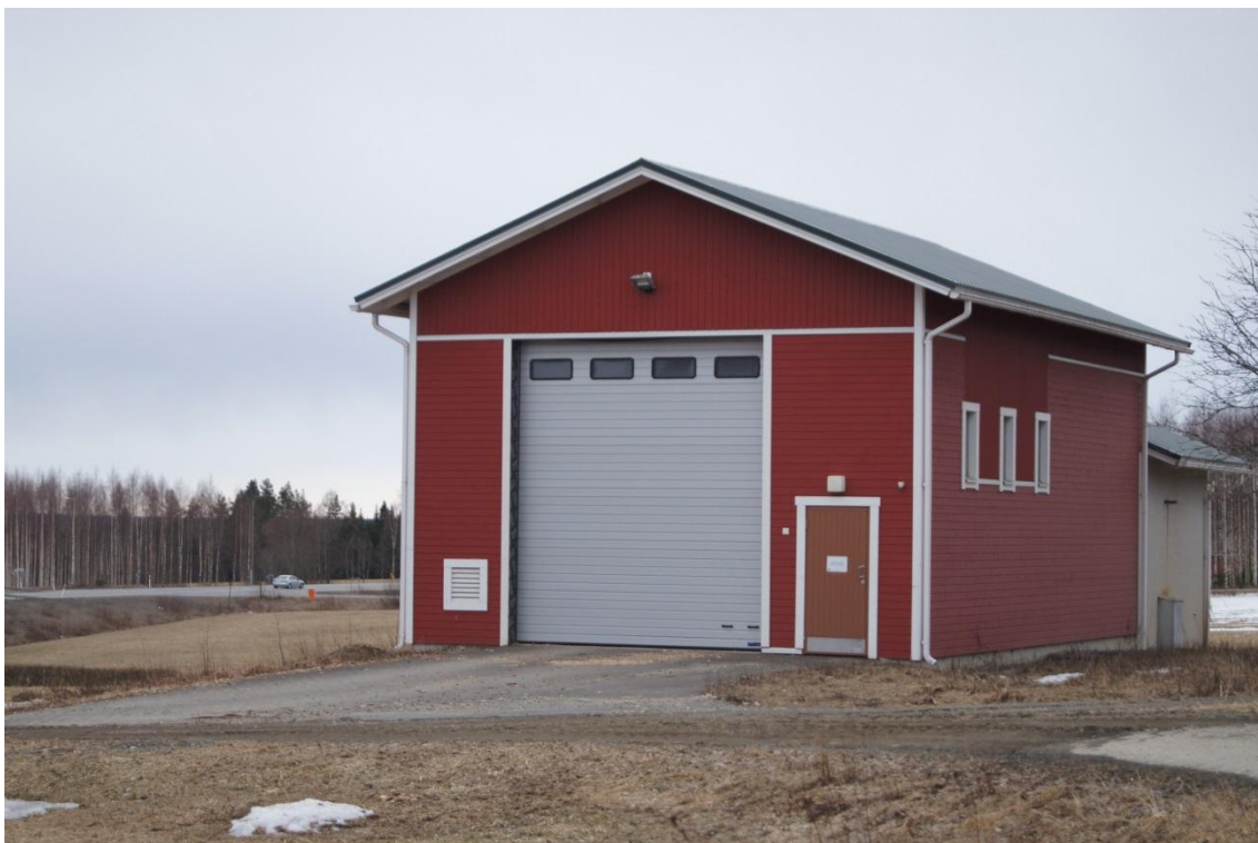
Kuva 2. Jakokosken lämpölaitos (Kuva: Antti Lukkarinen)
