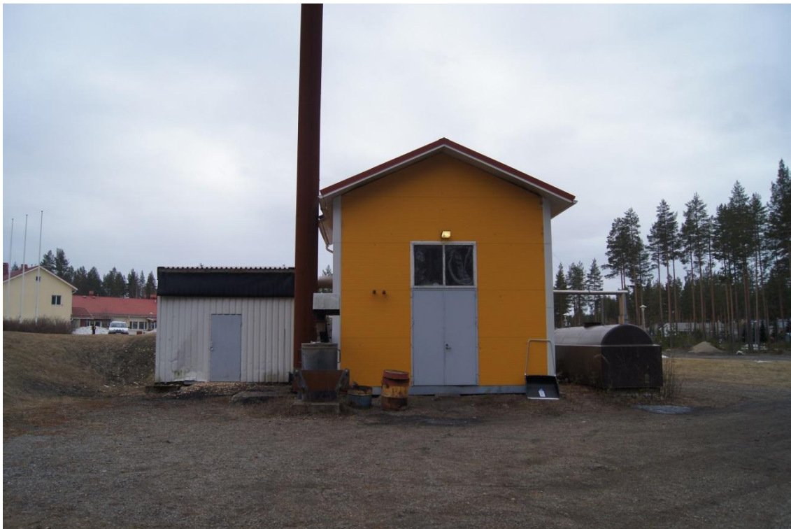
Kuva 1. Kylmäojan lämpölaitos (Kuva: Antti Lukkarinen)
