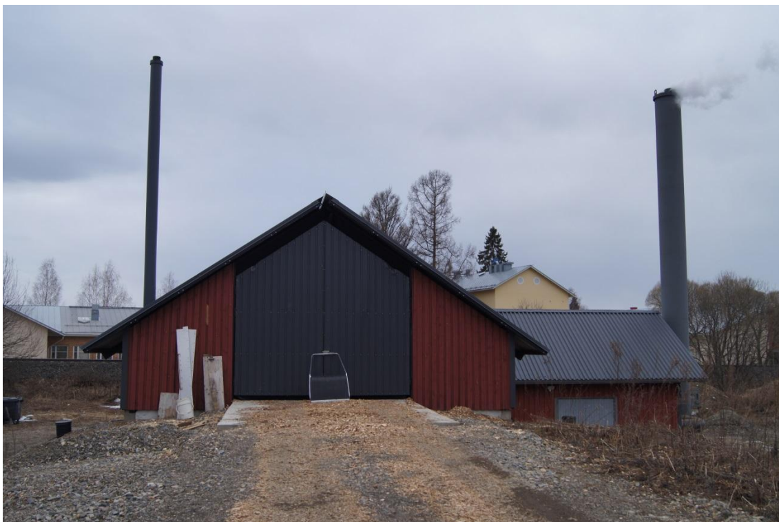
Kuva 4. Lehmon lämpölaitos (Kuva: Antti Lukkarinen)
