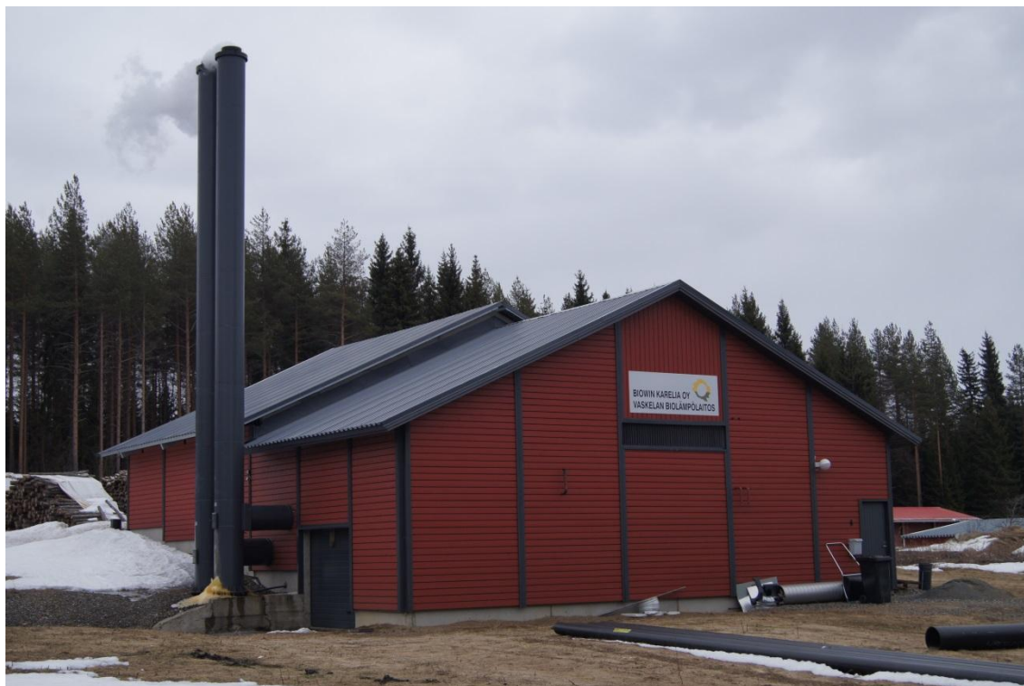
Kuva 5. Vaskelan lämpölaitos (Kuva: Antti Lukkarinen)
