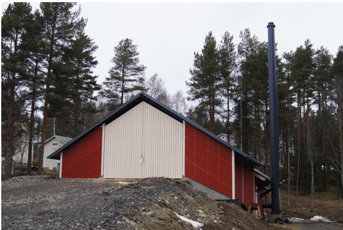
Kuva 3. Ukonharjun lämpölaitos (Kuva: Antti Lukkarinen)
