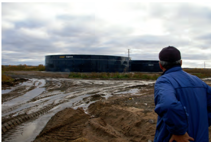
СНИМОК 3. Современные хранилища, сделанные из стали, для жидкого навоза крупного рогатого скота в республике Карелия, Россия (Фото Х.Хухта)
