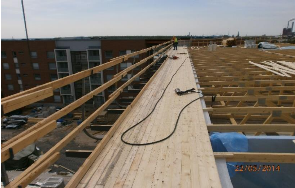
KUVA14. Rästäsalue sekä alakaiteet valmiina
