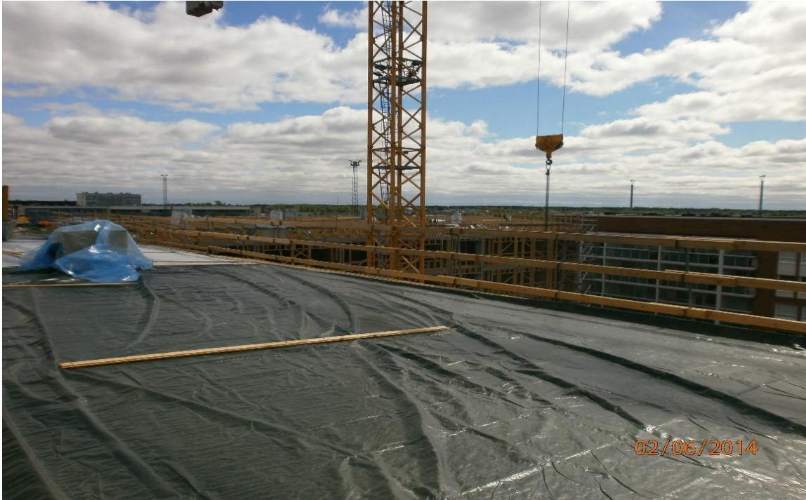
KUVA 20. Katon työnaikainen suojaus
