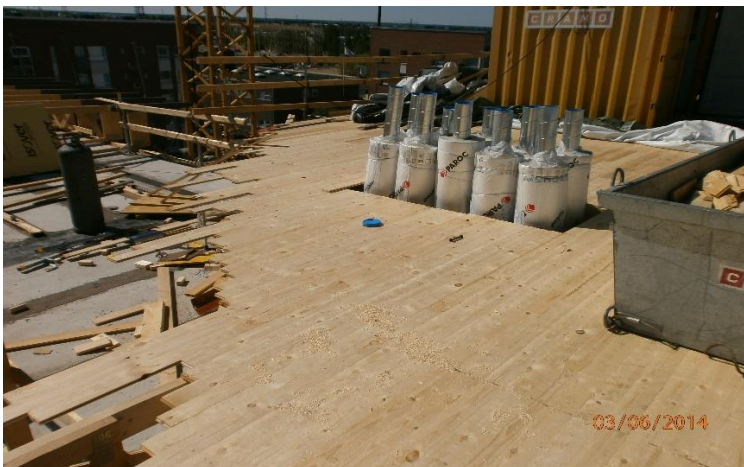
KUVA 16. Ilmastointi putket valmiina
