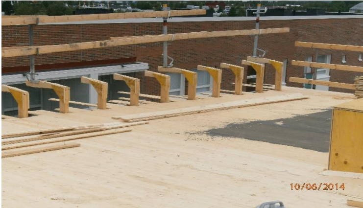
KUVA 17. Ykköslohkon päädyn runko valmiina
