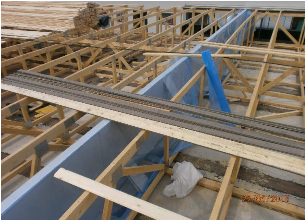
KUVA 8. EI-15-palokatko on valmiina ja suojattu muovilla
