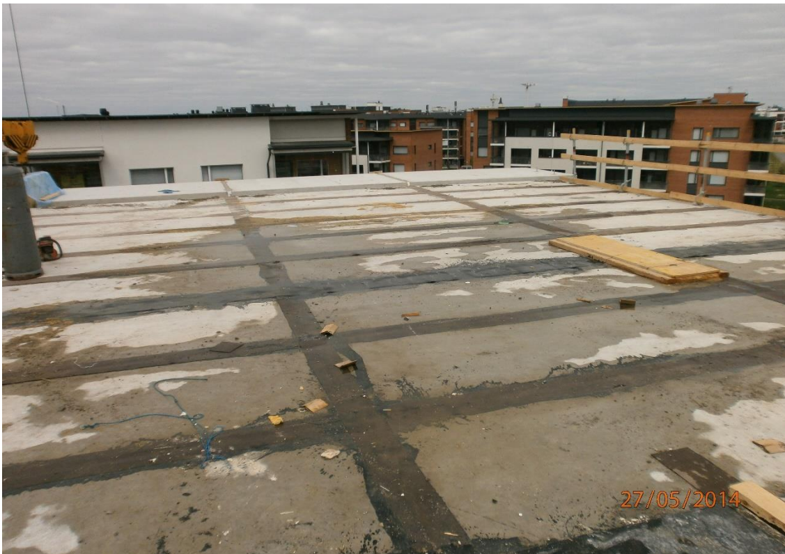
KUVA 2. Lohko 1:n pohjatyöt tehtynä
