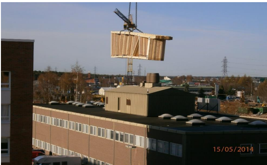
KUVA 5. Ristikkonipun nosto holville
