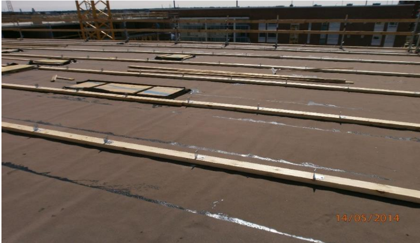
KUVA 4. Tukilankut ja kattoristikkokulmat on kiinnitetty
