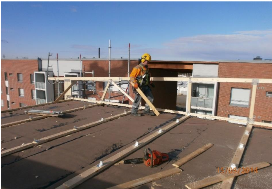
KUVA 6. Ensimmäisen ristikoiden asennus
