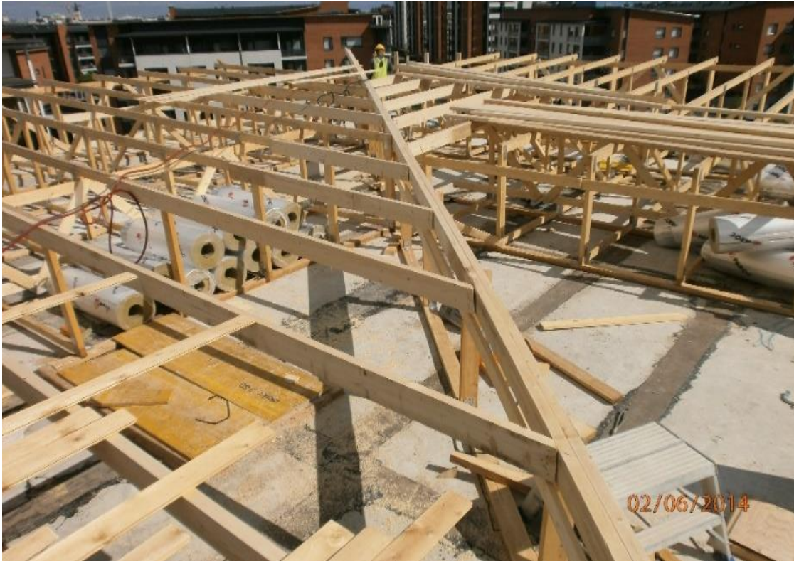
KUVA 11. Osa ristikoista on jatkettu jiiripuille
