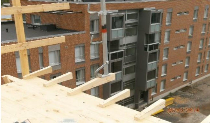
KUVA 15. Yläreunan reunapuut sekä holvikaide
