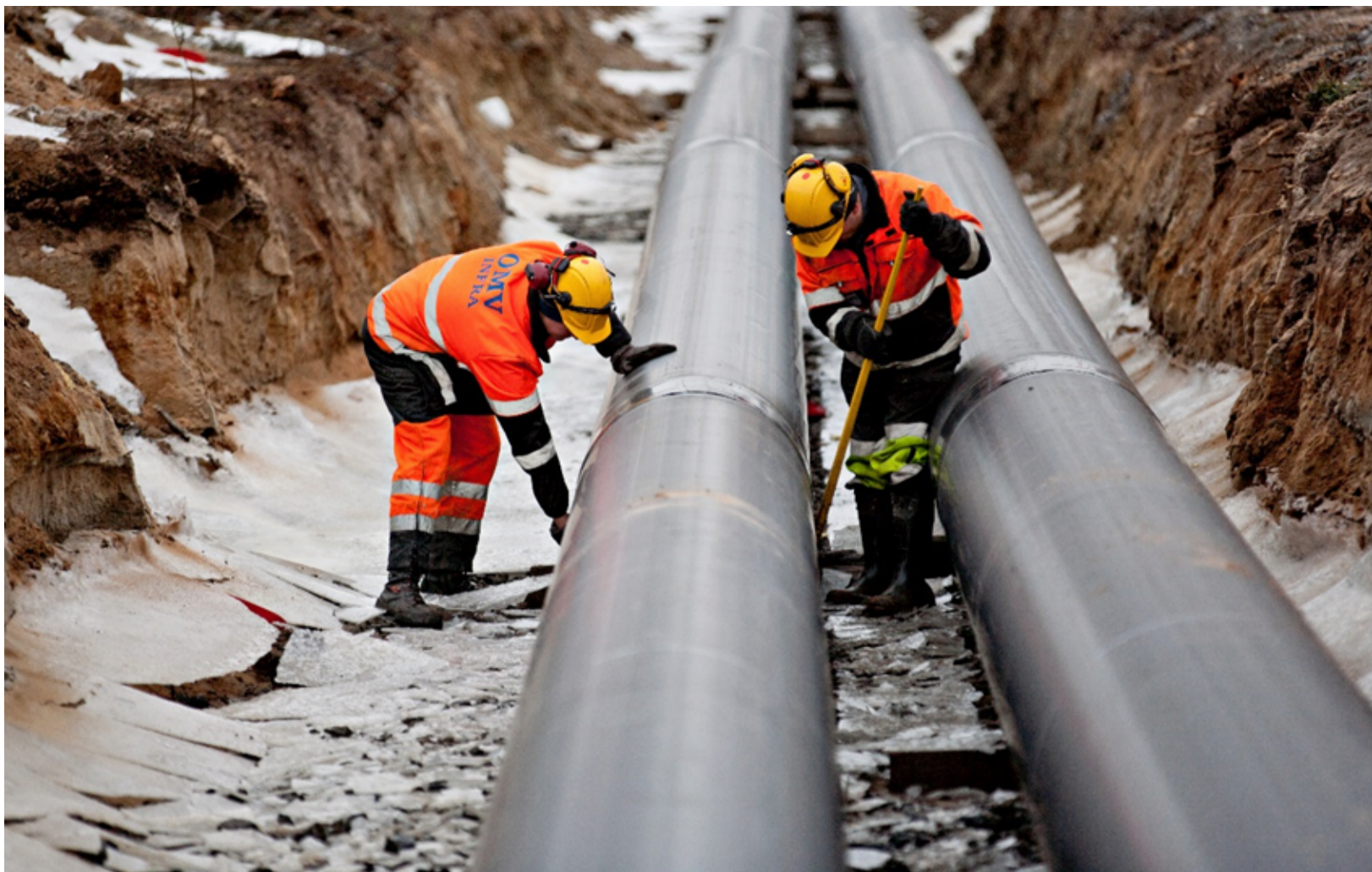
KUVA 1. Kaukolämpöputkien asennusta (kuvaaja: Studio Ukkoshuone, Jussi Tuokkola)
