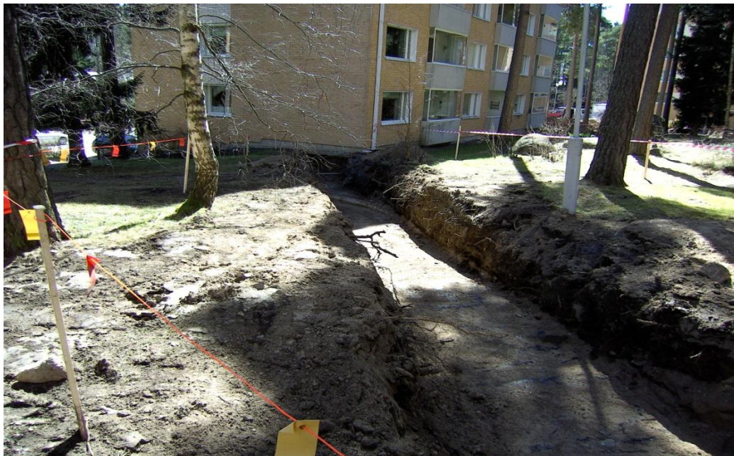
Kuva 3. Talojen välinen kaivanto.
