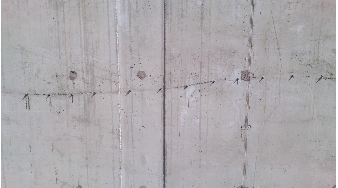
Kuva 13. Halkeaman injektointia varmuuden vuoksi. Ei välttämättä vuotokohta.
