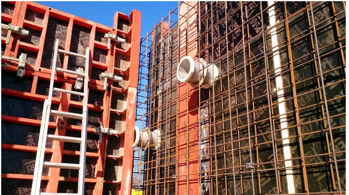
Kuva 8. Tulevan putkiston läpivientejä seinärakenteessa
