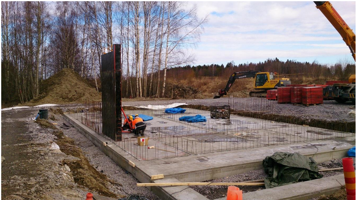
Kuva 6. Suurmuottien tukijalan asennus
