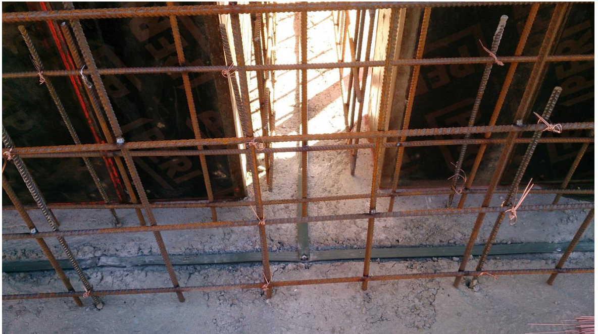
Kuva 7. Työsaumanauha asennettuna liitoskohtaan
