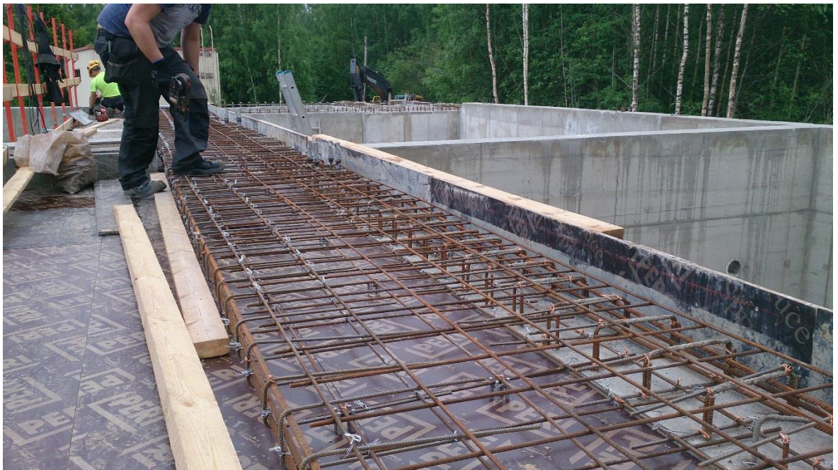
Kuva 11. Holvimuotin raudoitustyö käynnissä
