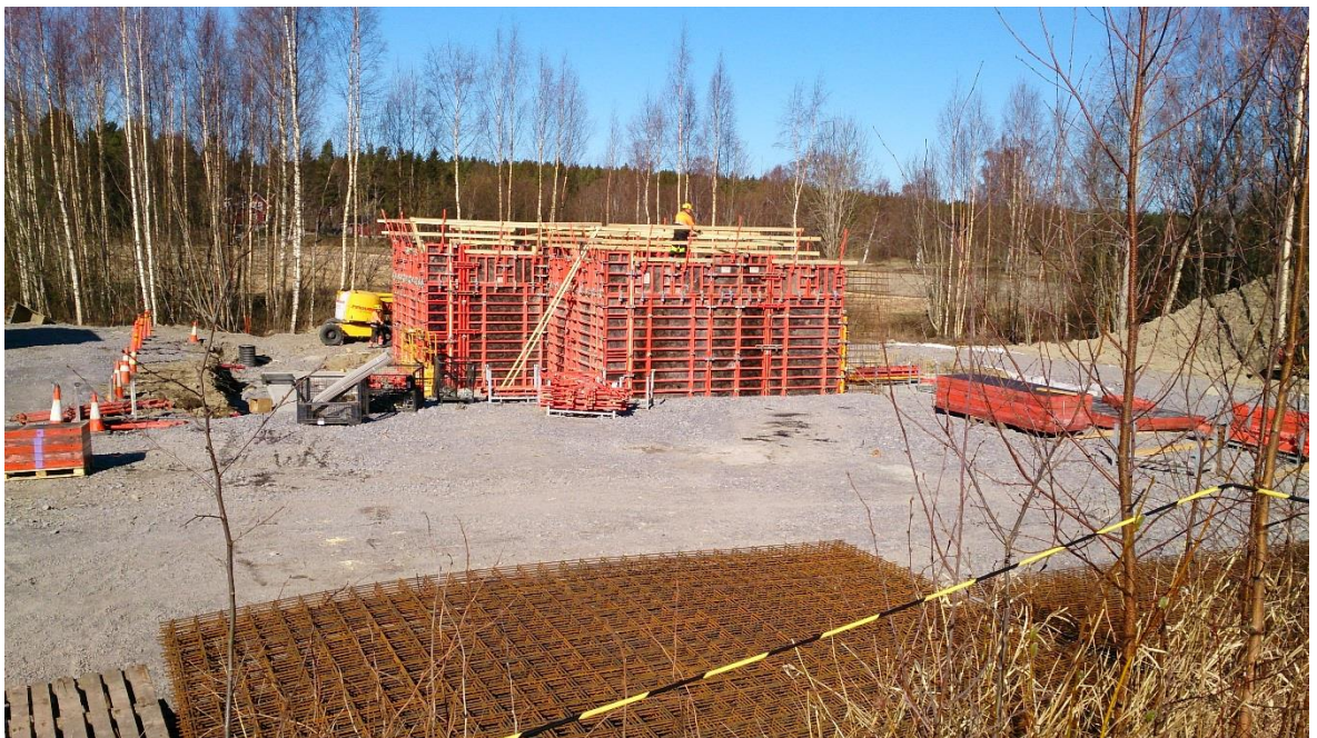
Kuva 10. Kaiteiden rakennusta betonointia varten
