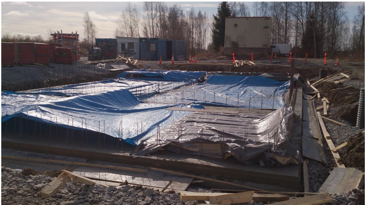
Kuva 5. Pohjalaatan jälkihoito käynnissä.
