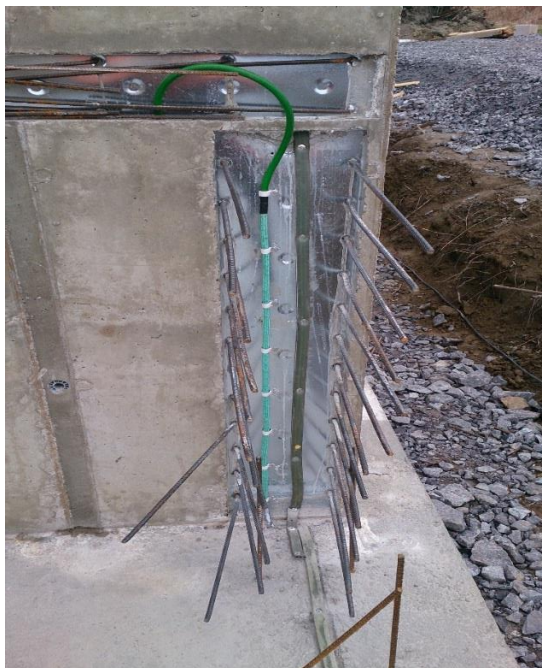
Kuva 12. Paisuva saumanauha ja injektointiletku asennettuna
