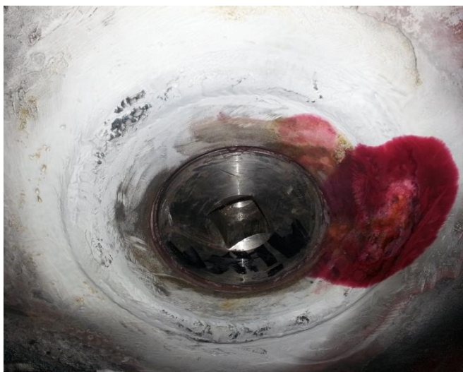
Kuva 24. Laivan painolastitankin vaihdettu tyhjennystulppa, testattu korjatun hitsisauman vuototiiviyttä tunkeumanesteellä. Kuvassa vuoto kierteistä, ei saumasta. (26.)
