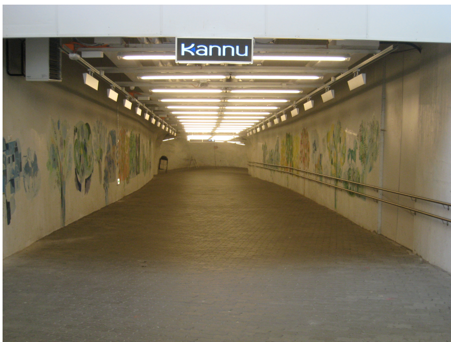
Kuva 2. Väestösuojan käytävää ulko-ovelta katsottuna. Oma kuva-arkisto.
