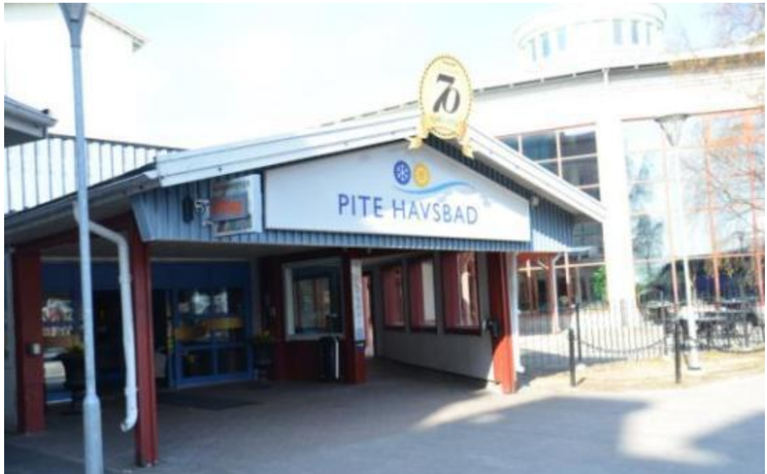
Kuva 7. Pite Havsbad, päärakennus, kylpylä, ravintola ja hotelli.
