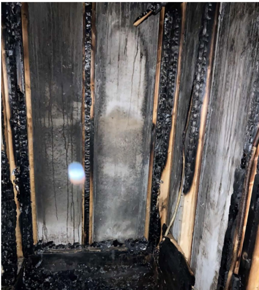
Kuva 5 a, b,c: Sammutustyöt suoritettu. [Ville Korhonen]
