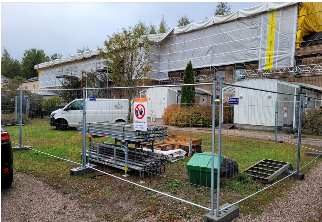
Kuva 7: JVT-työt aloitettu. [Ville Korhonen]
