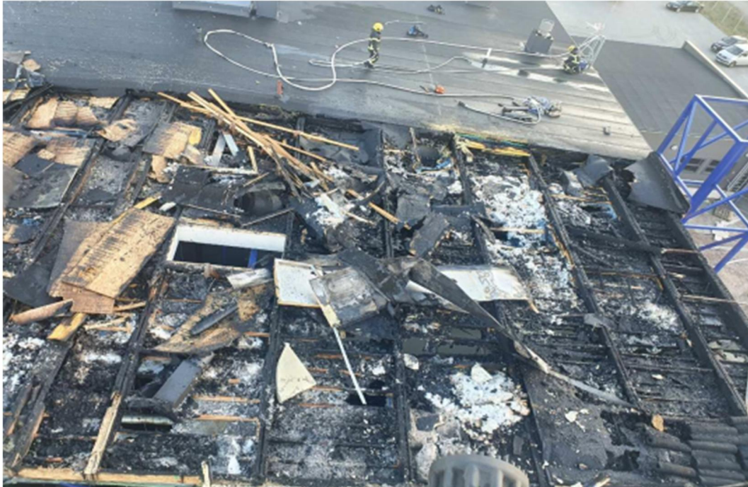
Kuva 10: Sammutustyöt ovat päättyneet rekkaterminaalien laajennustyömaalla. [Ville Korhonen]
